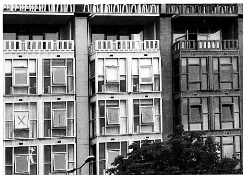
Het Groothandelsgebouw tijdens de renovatie in 2004. Links nog geschilderd en met enkel glas, rechts het beton gestraald en de kozijnen gevuld met isolatieglas
