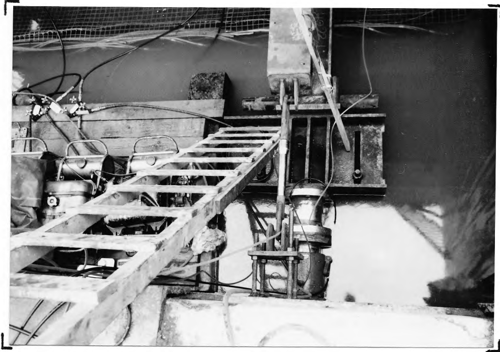
3. Drukdoos van boven afgezien (horizontaal).
