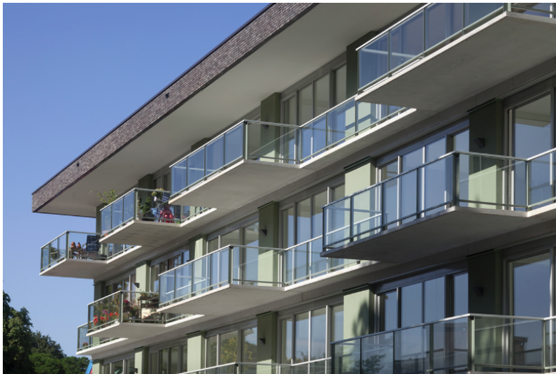
Figure 1: Ultra thin balconies at Huize het Oosten
