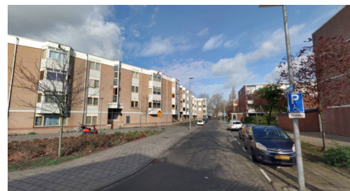
Fig 3.5.10 | Feijenoorddijk, Feijenoord | Cyclomedia, 2024
