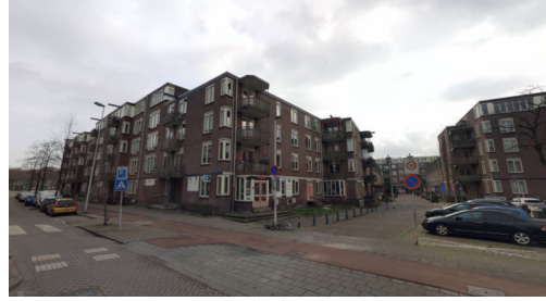
Fig 3.9.2 Rottestraat, Oude Noorden | Cyclomedia, 2024
