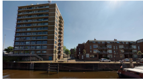
Fig 3.4.6 | Achterhaven, Delfshaven | Cyclomedia, 2024
