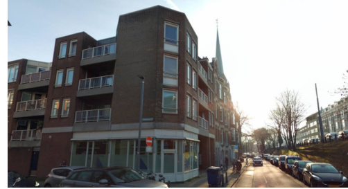
Fig 3.7.2 Beneden Oostzeedijk Kralingen | Cyclomedia, 2024
