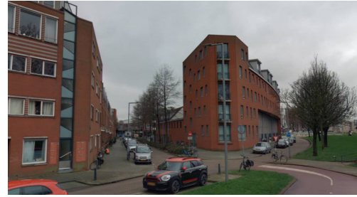
Fig 3.8.2 | Dokstraat, Oud-Charlois | Cyclomedia, 2024
