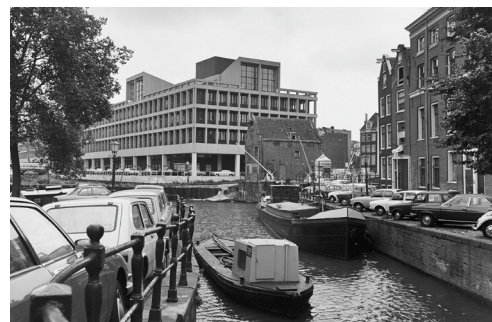
Fig 1.1.2 Maupoleum | Rijksdienst voor het Cultureel Erfgoed, 1976
