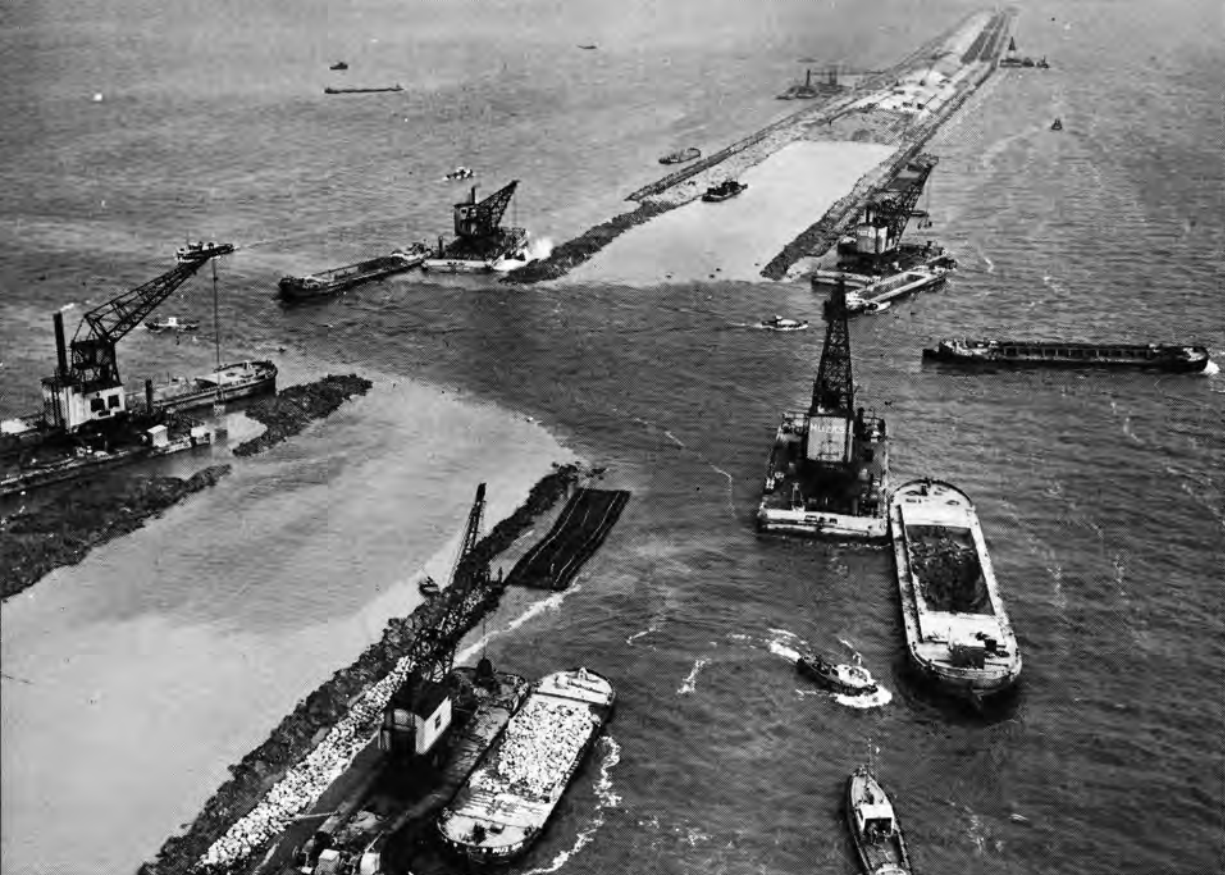
57. 1956. Sluiten van de dijk van Oostelijk Flevoland.
