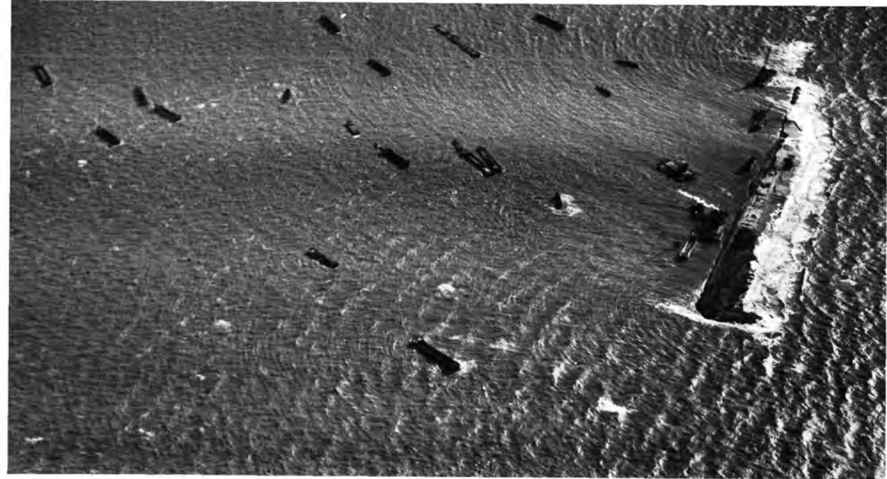
52. Zelfs het eerste begin van de dijk over de Oude Zeug geeft bij slecht weer en hoge golven een goede bescherming aan het aannemersmaterieel.
