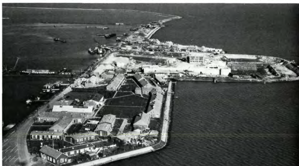
56. Hier ontwikkelt zich het bedrijvige Lelystadhaven, waartegen de bouwput voor het gemaal Wortman en de Noordersluis aansluit.
