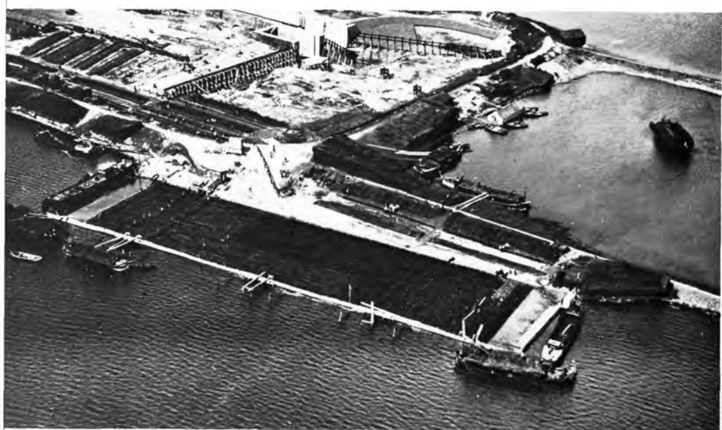
24. Bij Den Oever is een dok gemaakt om de grote zinkstukken voor de Vlieter regelmatig te kunnen vervaardigen.
