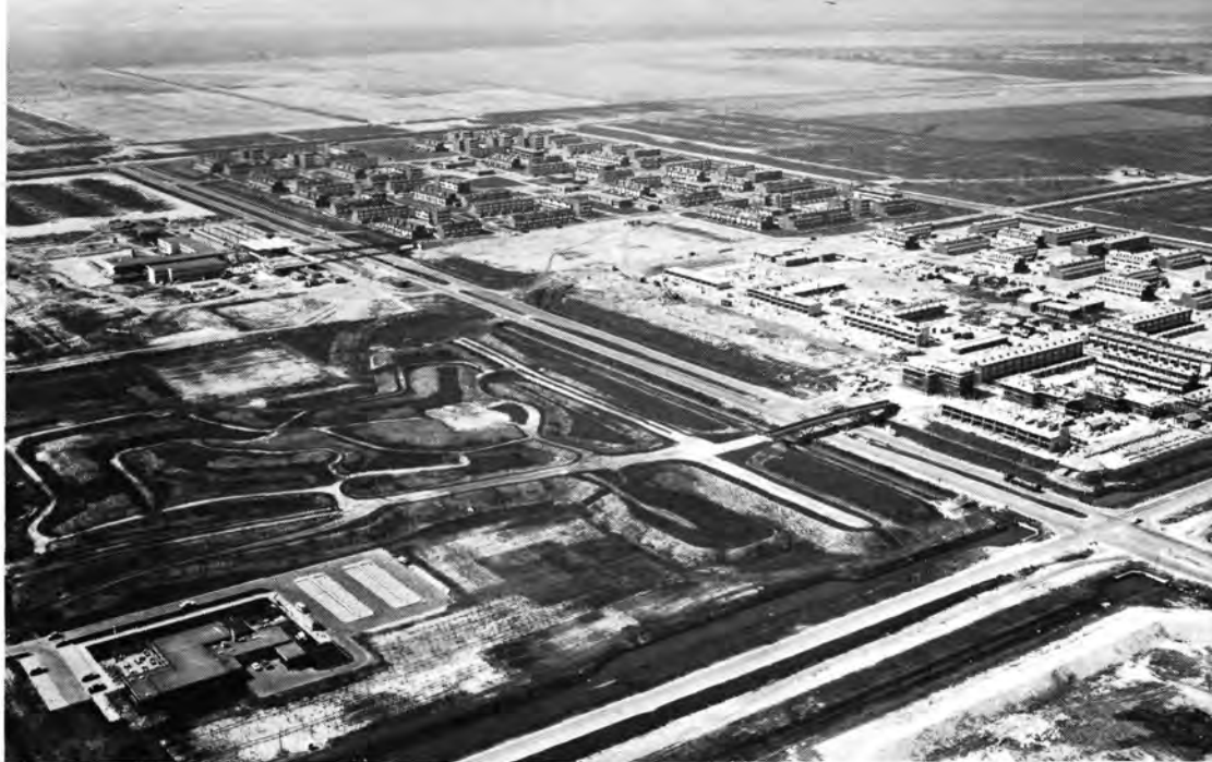
124. De bouw van Lelystad komt flink op gang. De stad krijgt moderne aspecten.
