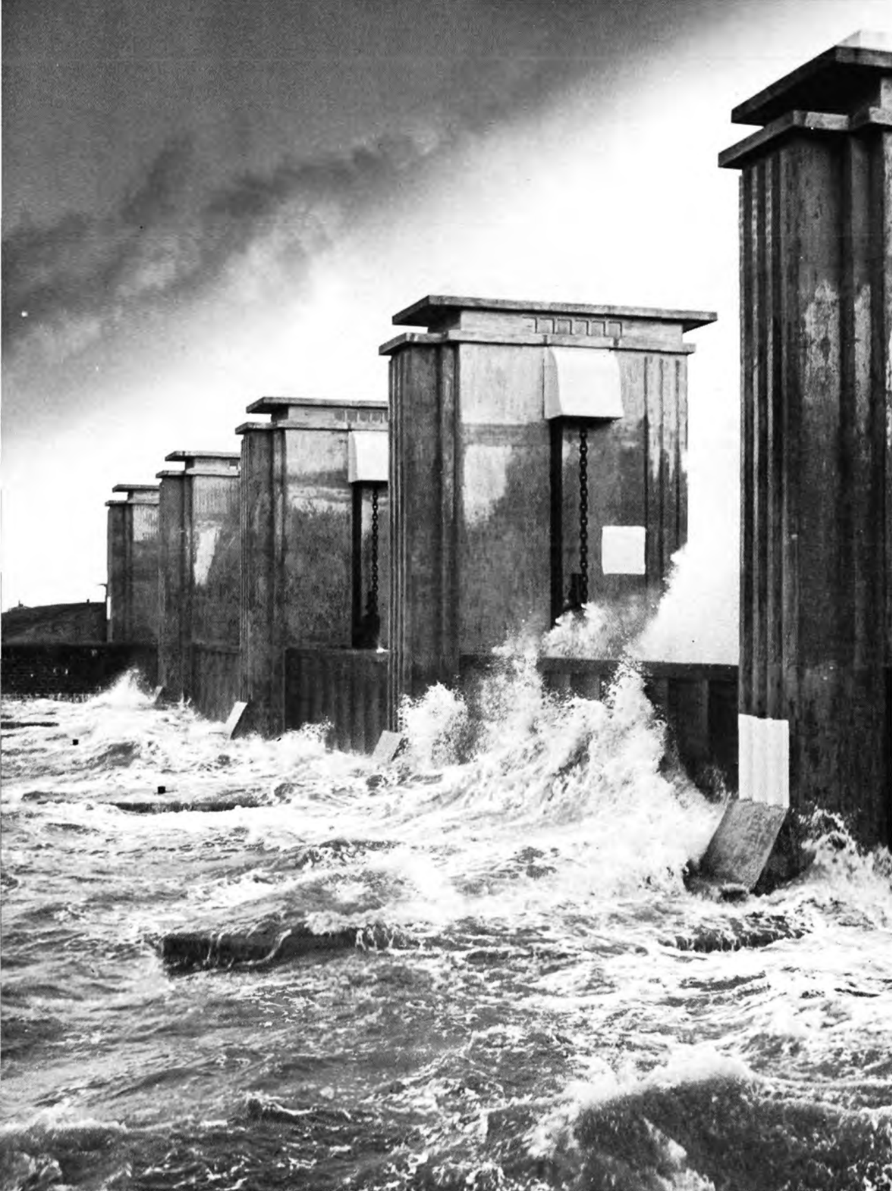
50. De golven beuken de uitwateringsluizen. De waterstand is bijna gelijk met de koppen van de pijlers. Het water spuit achter de militaire balk tussen de heftorens omhoog.
