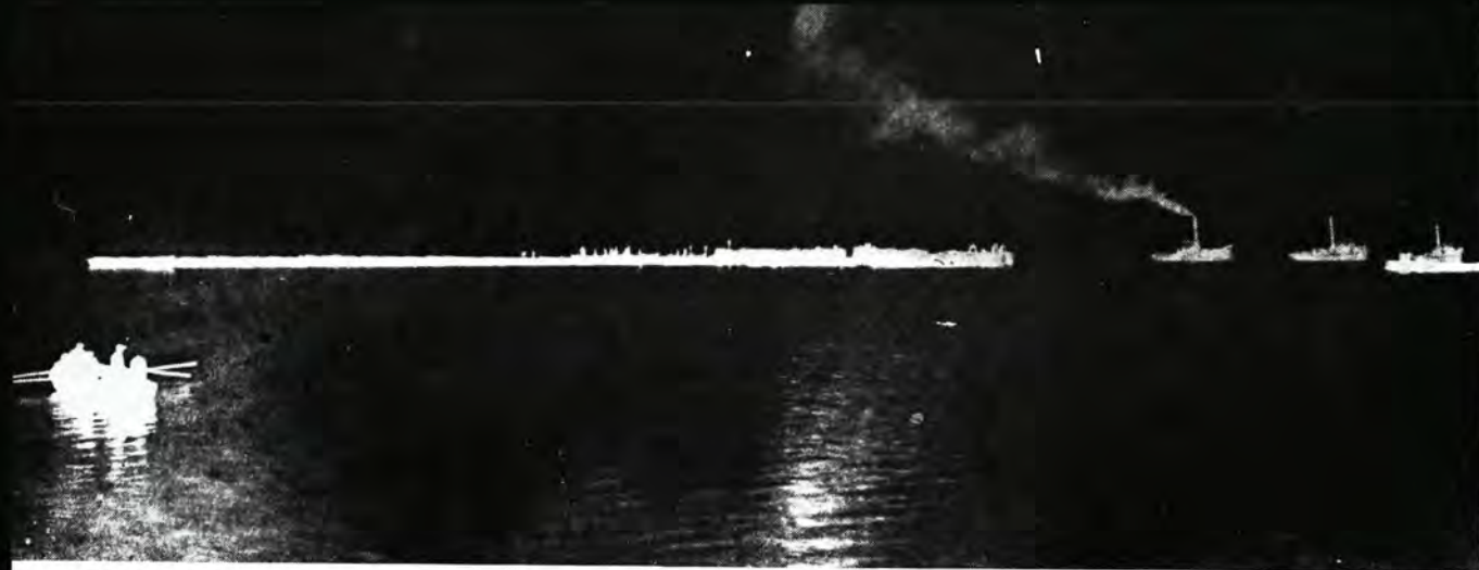
10. Het slepen van de zinkstukken naar hun plaats is een spectaculaire gebeurtenis ( negatieve druk ).
