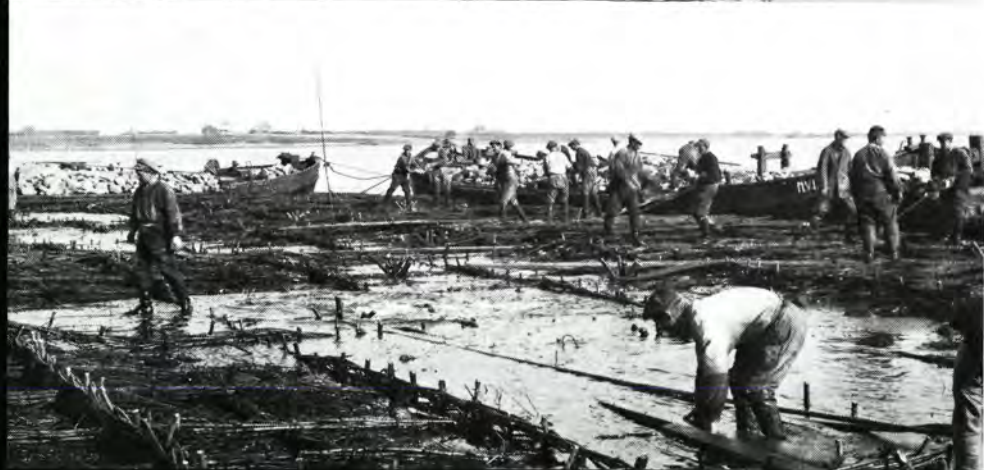
13. De ballast wordt met de hand van de dekschuiten naar het stuk gebracht.
