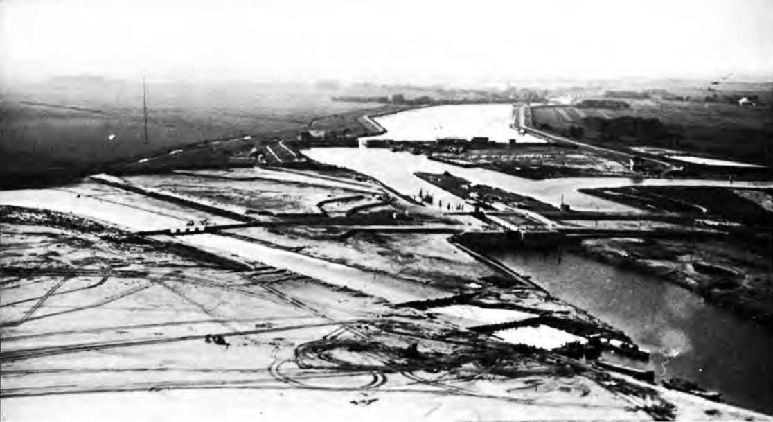
114. De Westfriese sluis bij Kolhorn en de tijdelijke uitlaat van het Groetkanaal.
