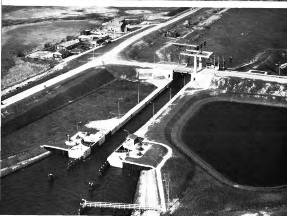
66. De Roggebotsluis gereed. Het hoge noordelijke sluishoofd keert tegen het IJsselmeer. In het Zuiderhoofd de waaierdeuren. In de put (rechts) kunnen spuisluizen worden gemaakt.
