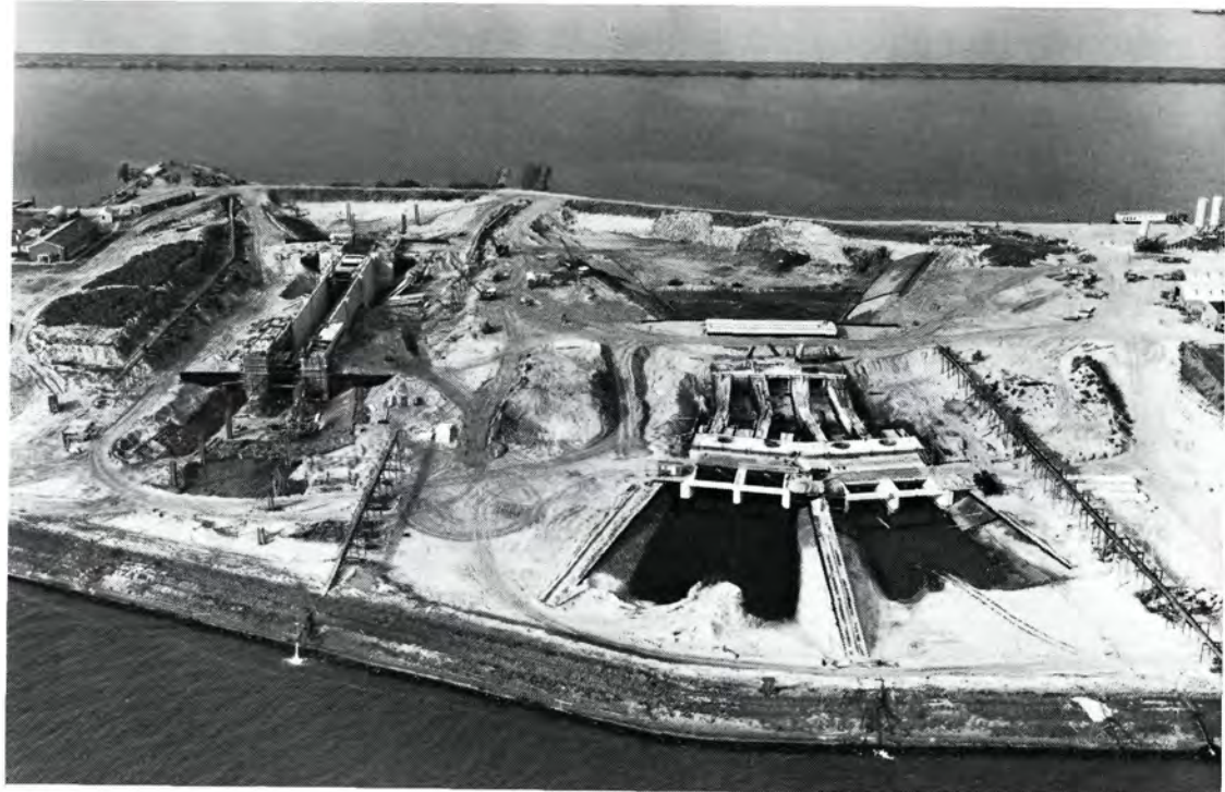
90. Achter de bouwput het toekomstige Oostvaardersdiep.
