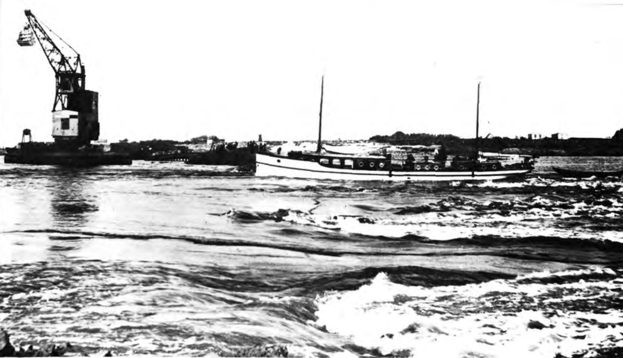
18. Amsteldiep 1924. ZW meet voor het eerst een stroom van meer dan 3 m/sec.
