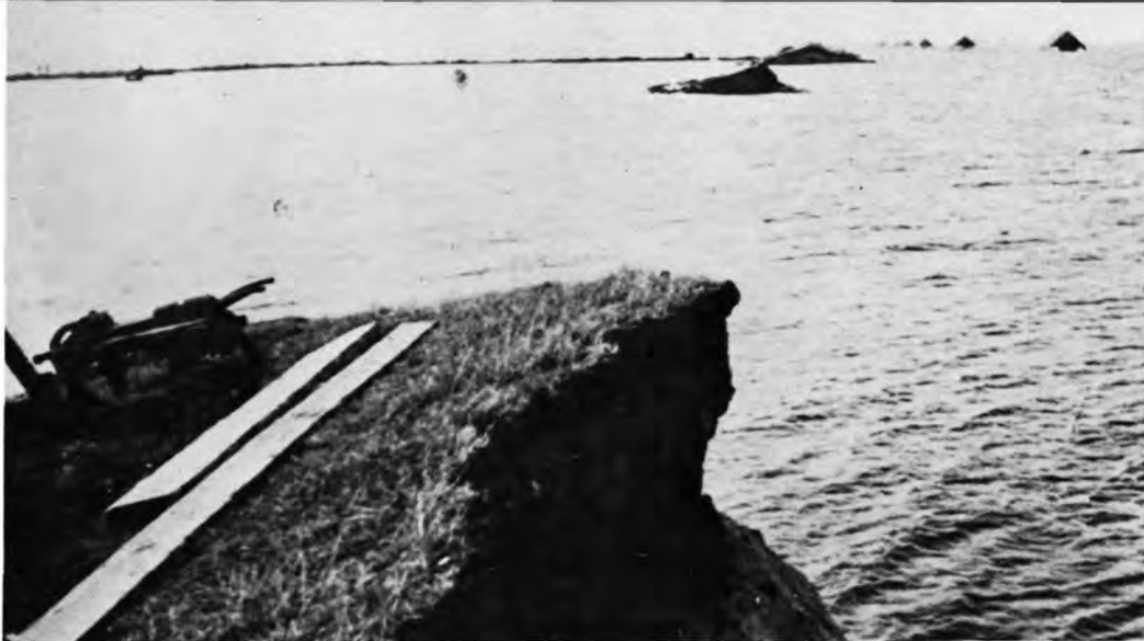
111. Uitwerking van de bommen en van het stromende water op de dijk van de Wieringermeer.
