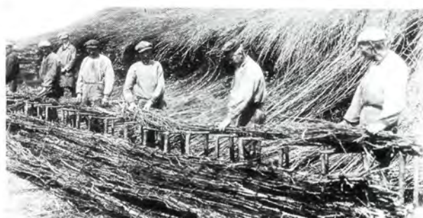
10. Het slepen van de zinkstukken naar hun plaats is een spectaculaire gebeurtenis ( negatieve druk ).
