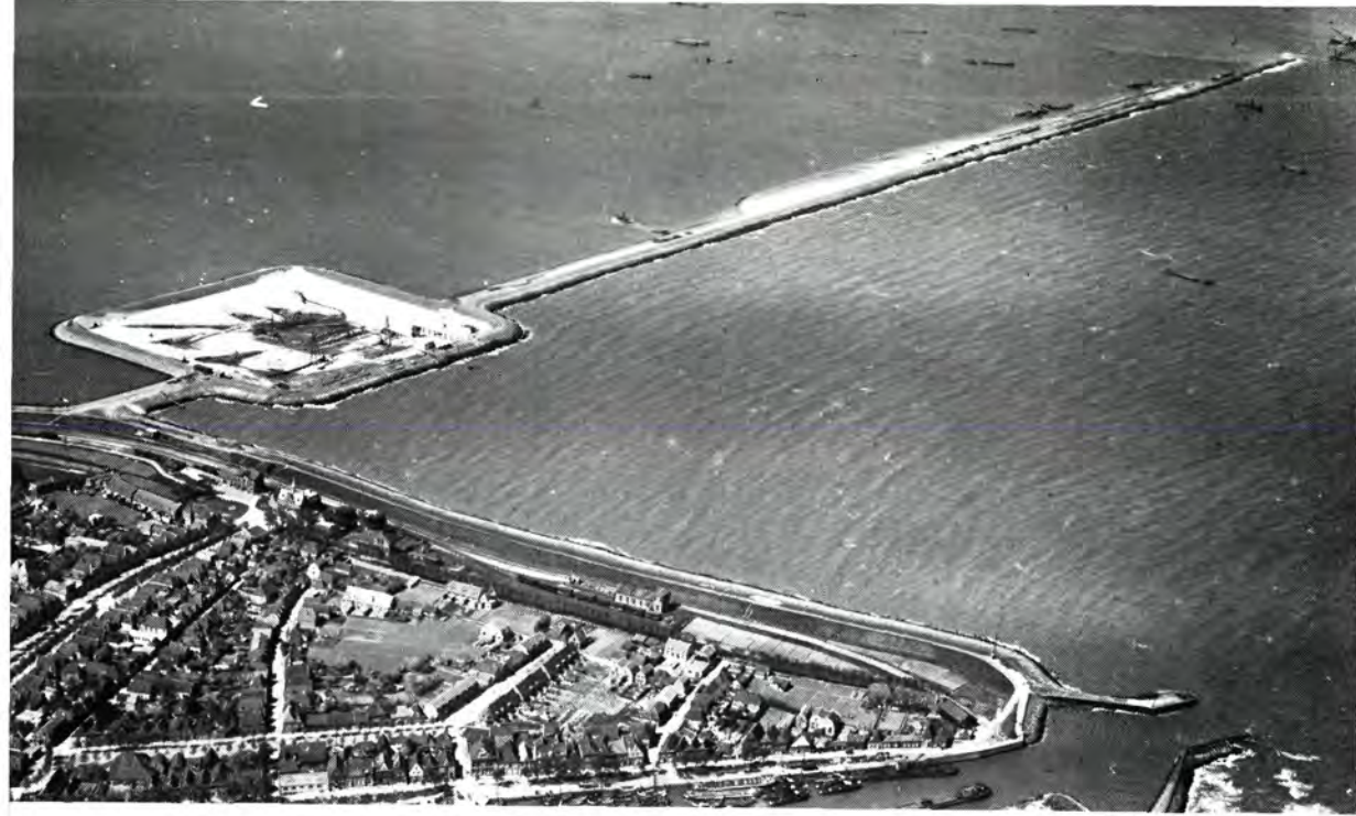
81. 1928. De bouwput buiten de zeedijk bij Medemblik en de dijk van de Wieringermeer.
