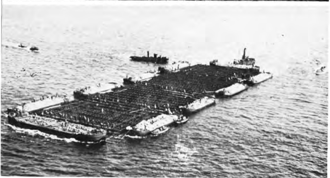
25. Een groot zinkstuk is op zijn plaats gekomen. Het ballasten begint.
