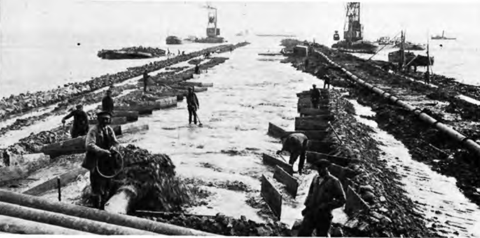
5. Het door de perszuiger aan- gebrachte water stroomt weg. Het zand blijft liggen. De dijk groeit.
