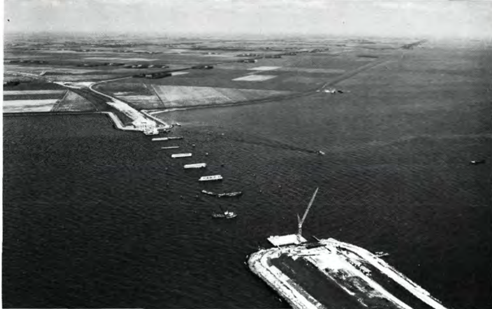
62. Bouw van de pijlers.
