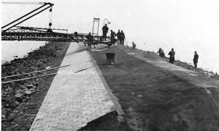
17. Glooiing van betonzuilen. De Afsluitdijk heeft (bijna) geen asfalt, maar verscheidene polderdijken wel.
