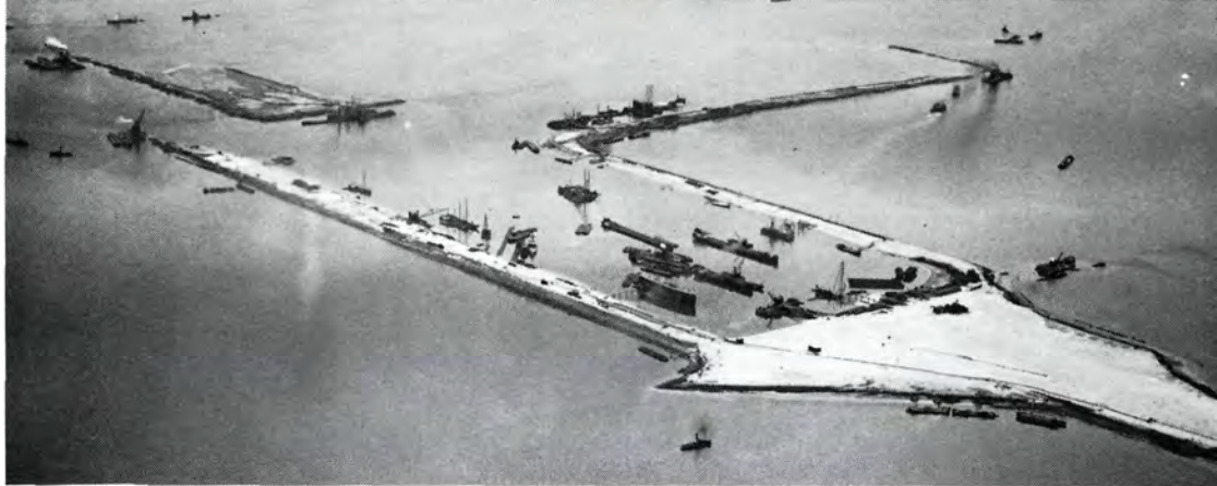
47. Tegelijkertijd werkhaven en bouwput.
