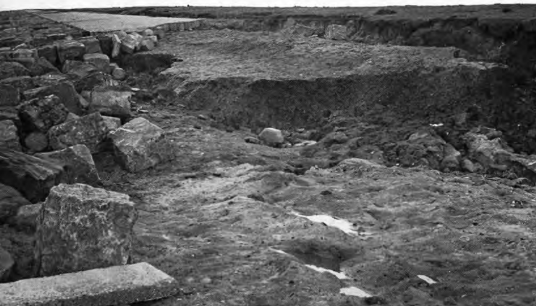
35. De stormvloed van 1953 heeft de steenglooiing door elkaar geslagen, maar de keileemdam is niet erg aangetast.
