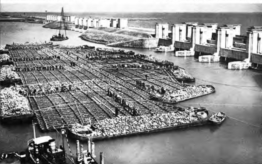
45. De kuil in de bodem wordt afgedekt met een zinkstuk.
