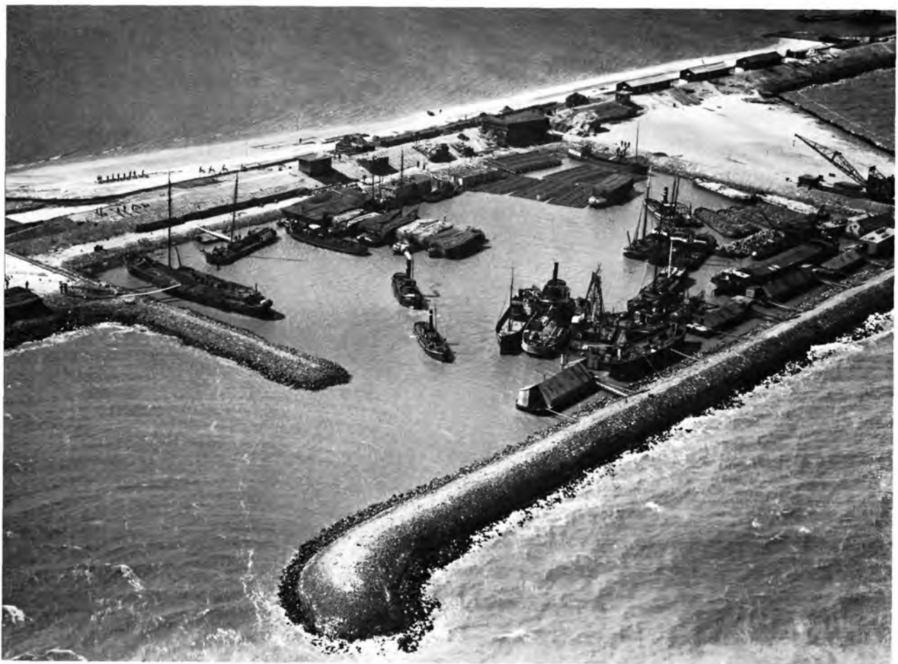
53. Werkhaven Oude Zeug. Woon- en werkplaats. Gelegenheid voor lossen, opslaan en overslaan van materialen. Bouwplaats voor zinkstukken (achterin). Vluchthaven bij storm en bij ijsgang. Mei 1928.
