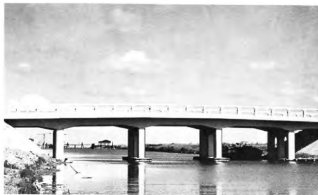
103. Vaste brug over een hoofdkanaal.
