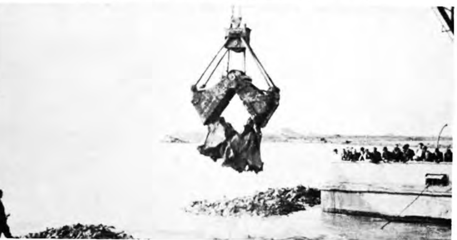
8. De grijper gaat open als hij te bestemder plaatse is aangekomen.
