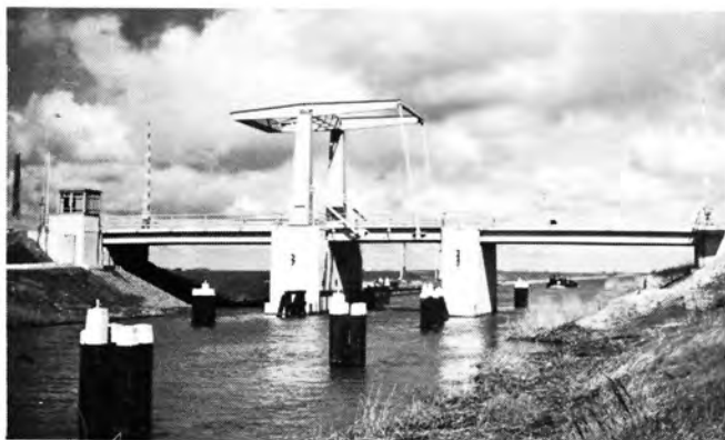
102. Ophaalbrug over een hoofdkanaal
