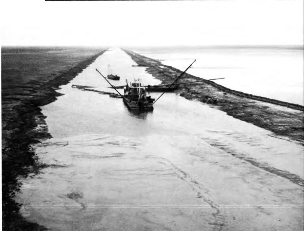
98. Vóór de polder droog was, is het kanaal weer grotendeels dichtgeslibd. Het secundaire baggerwerk is nodig om het weer onder profiel te brengen.
