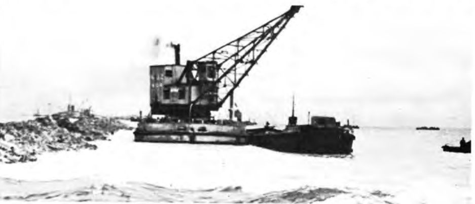
7. De grijperkraan haalt de keileem uit de bak.
