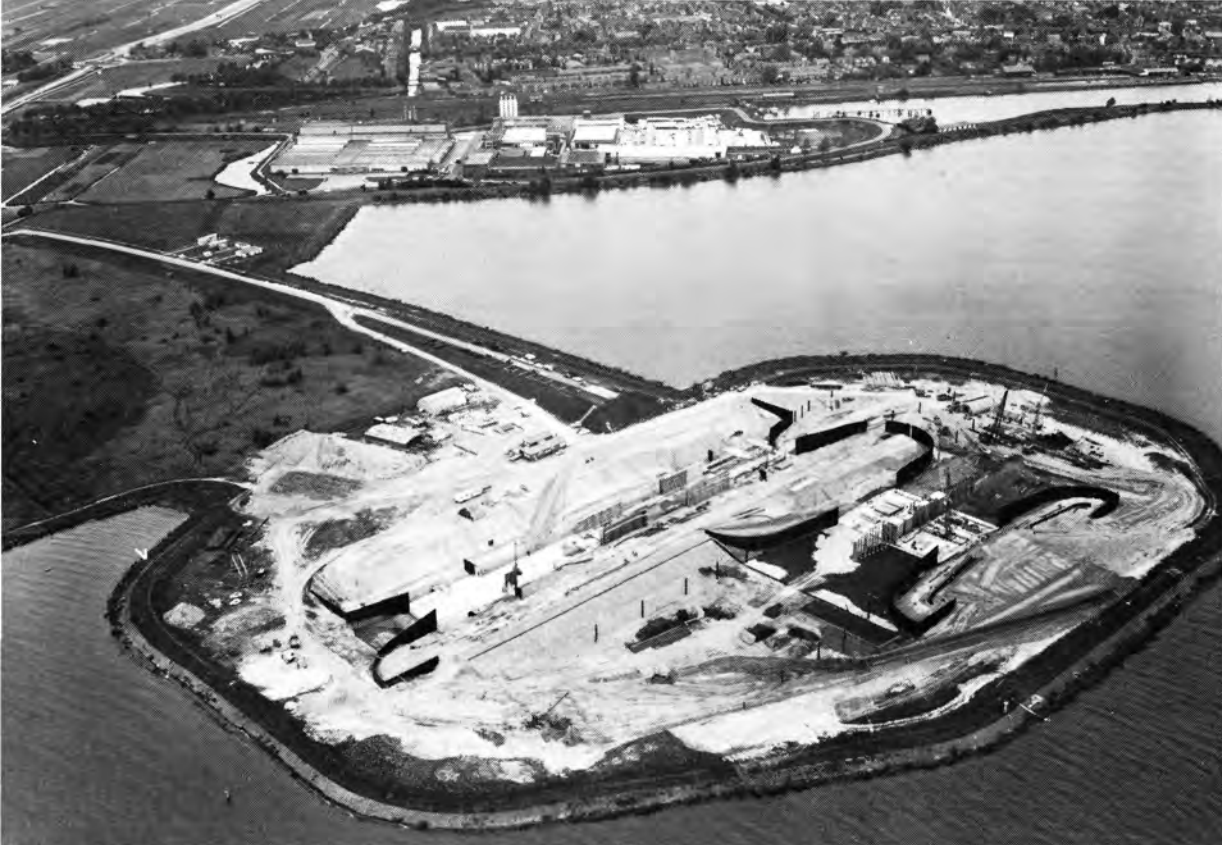
60. De sluizen bij Enkhuizen, die toegang geven tot de westelijke randmeren, waren in de zomer van 1970 in aanbouw in de sluisput, die jaren heeft moeten wachten.
