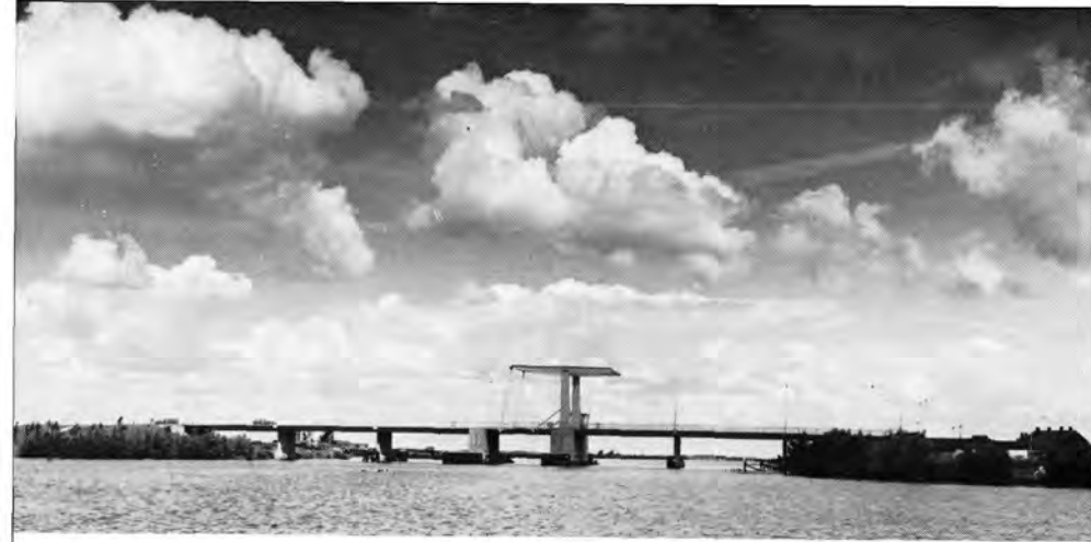
64. De brug over het Veluwemeer bij Elburg.
