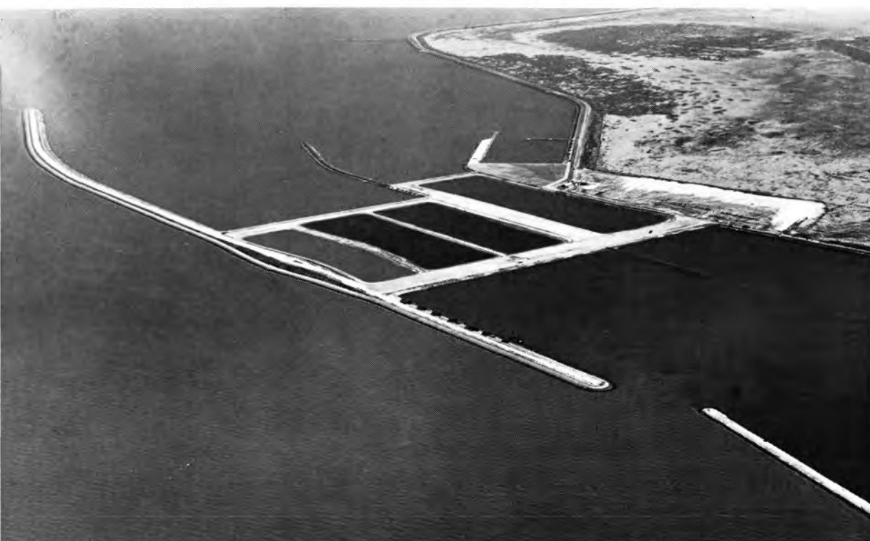
61. De bouwput voor de Houtribsluizen dwars over het Oostvaardersdiep, is in 1956 gemaakt, maar de sluizen zelf komen pas na 1970. De leidam (rechts) die in 1953 de werkhaven van 'perceel P' beschermde, ligt niet precies op de plaats waar de dijk van de Markerwaard moet komen. Tegen het juist drooggevalen Oostelijk Flevoland is een jachthaventje aangelegd.
