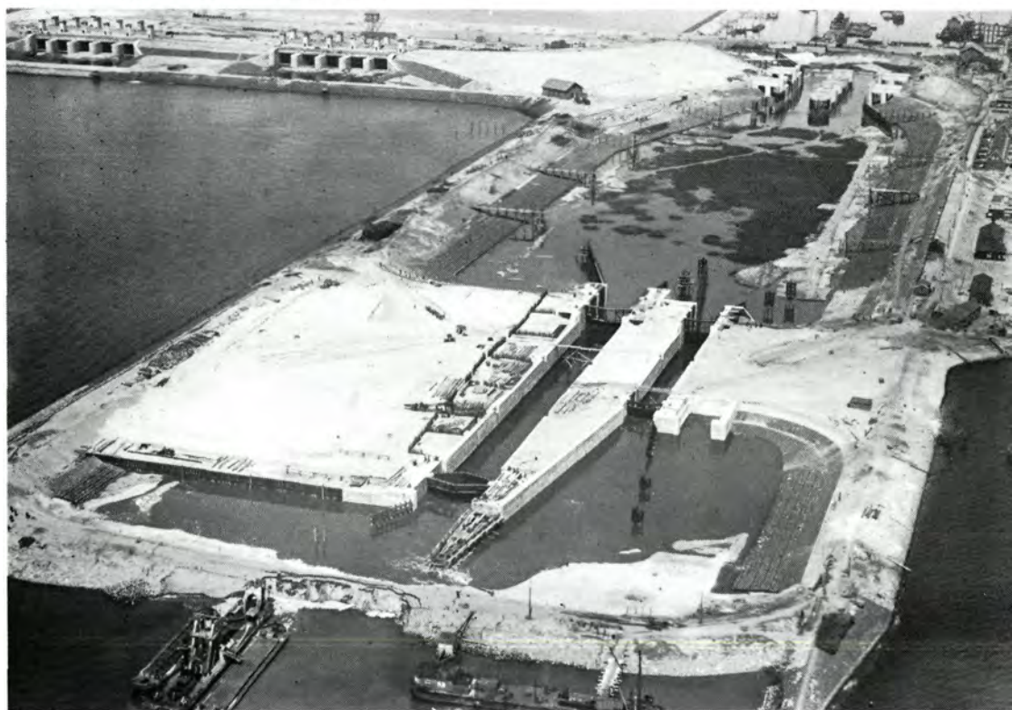
49. Onderbouw van schutsluizen, draaibruggen en uitwateringsluizen is gereed. Er wordt begonnen aan het wegbaggeren van de ringdijk.
