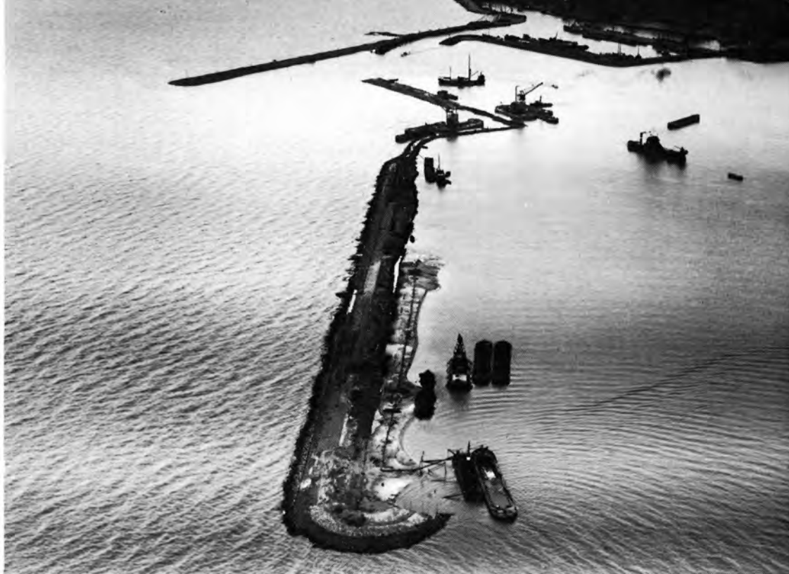
116. 1936. Het begin van de Noordoostpolder. Werkhaven Urk en de dijk om de toekomstige bouwput van de Vissering (in de bocht rechts).
