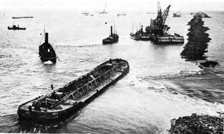
6. De onderlosser is op het punt de keileem ter plaatse te deponeren. De sleepboten hebben hun werk gedaan.
