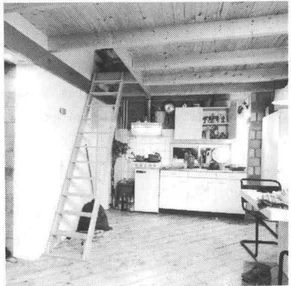
Afb. 25 : Uitbreidingen van de tussenverdiepingen met verplaatsing van de oorspronkelijke ladder (A2 nr.12 en A1 nr.7).
