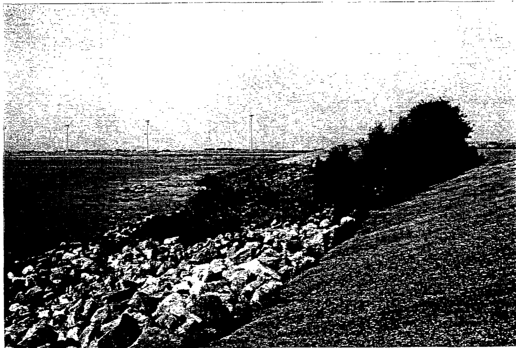
Grevelingendam, Breuksteen gepenetreerd met gietasfalt met ruigte begroeiing
