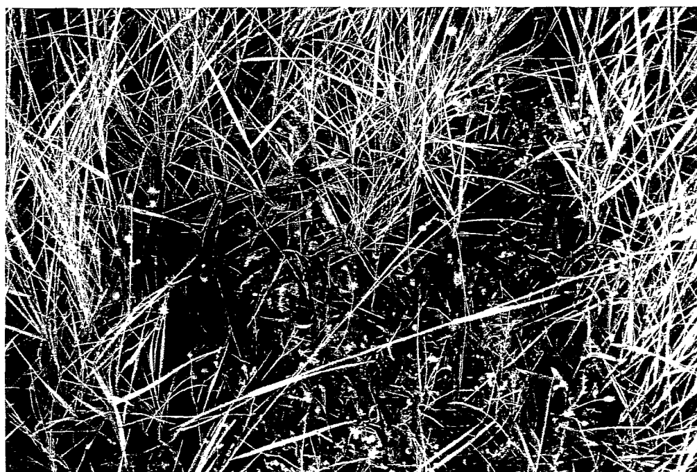
Begroeiing van kweek door open steenasfalt, Tholen
