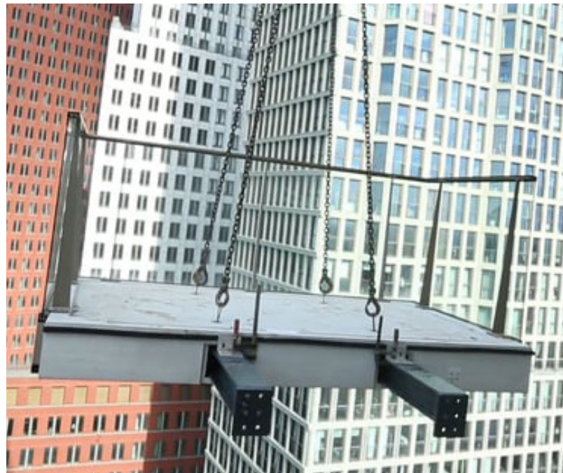
Assembly of balconies Wijnhaven Kwartier https://tasfilms.nl/portfolio/bedrijfsvideo-bouw-film/
