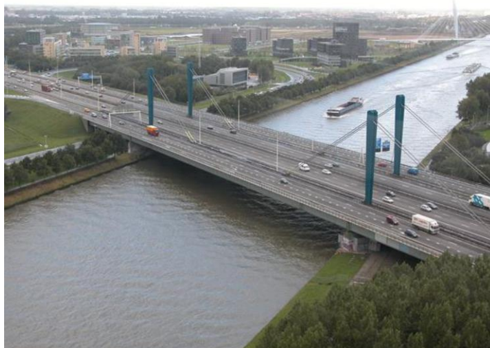
Figure 52 – Overview of the Galecopperbrug (Beeldbank RWS, 2004)
