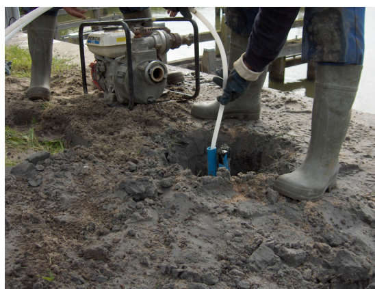
Figuur 7.9: de uitvoering van boring B6. Het schoonzuigen van het filter.
