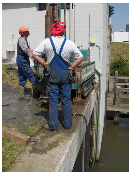
Figuur 7.9: de uitvoering van boring B6. Het schoonzuigen van het filter.
