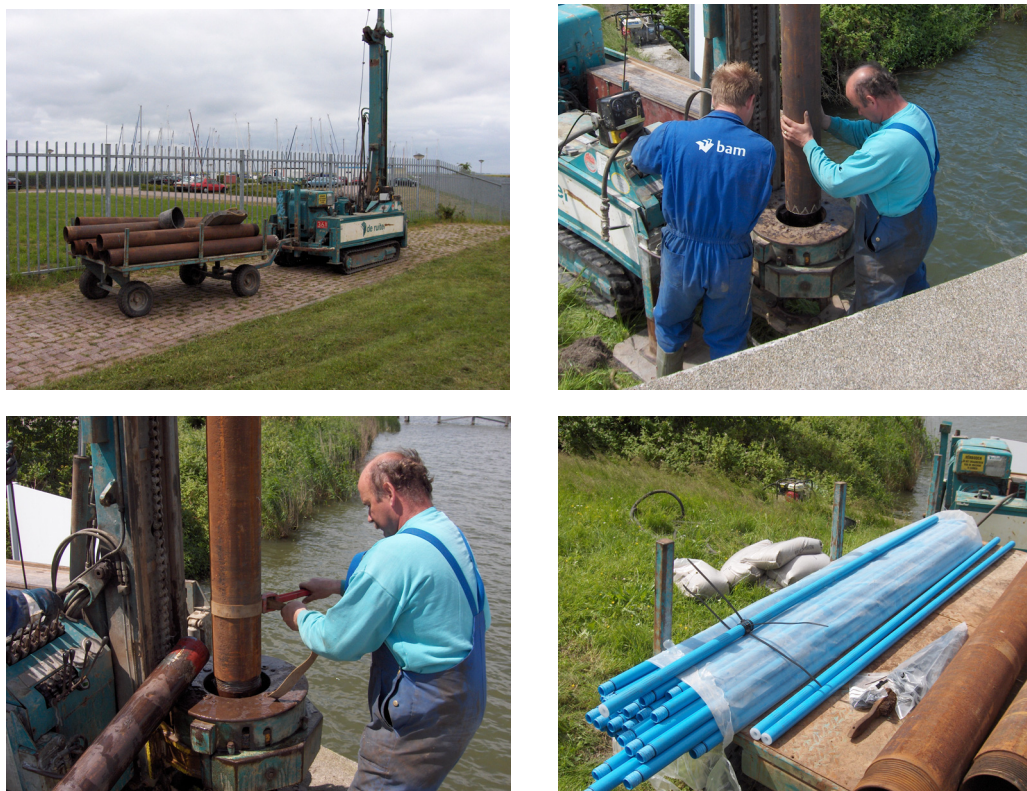
Figuur 7.8: uitvoering pulsboringen. Vanaf linksboven met de klok mee: materieel, plaatsen eerste casing in B1, peilbuizen, in elkaar draaien van de casings.
