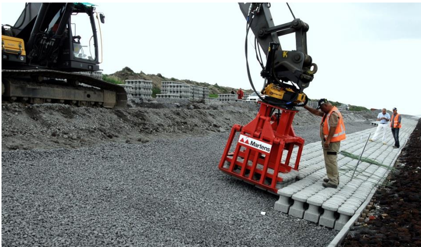
Figuur 1.1 Aanleg Hillblocks op dijk
