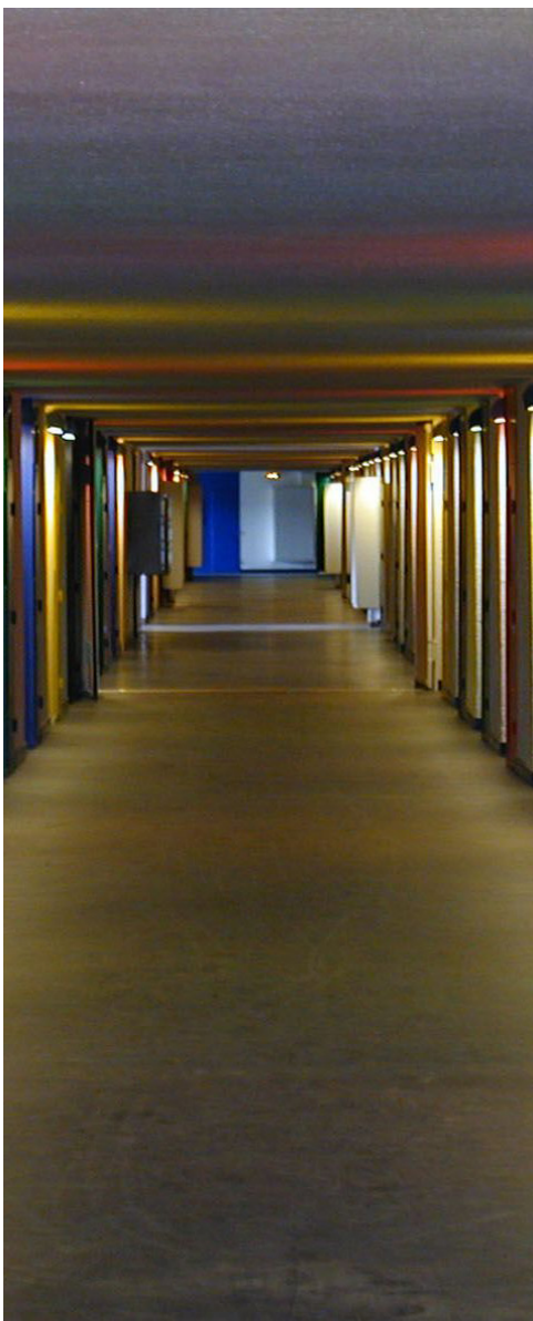
fg. 30 Unite d'habitation corridor
