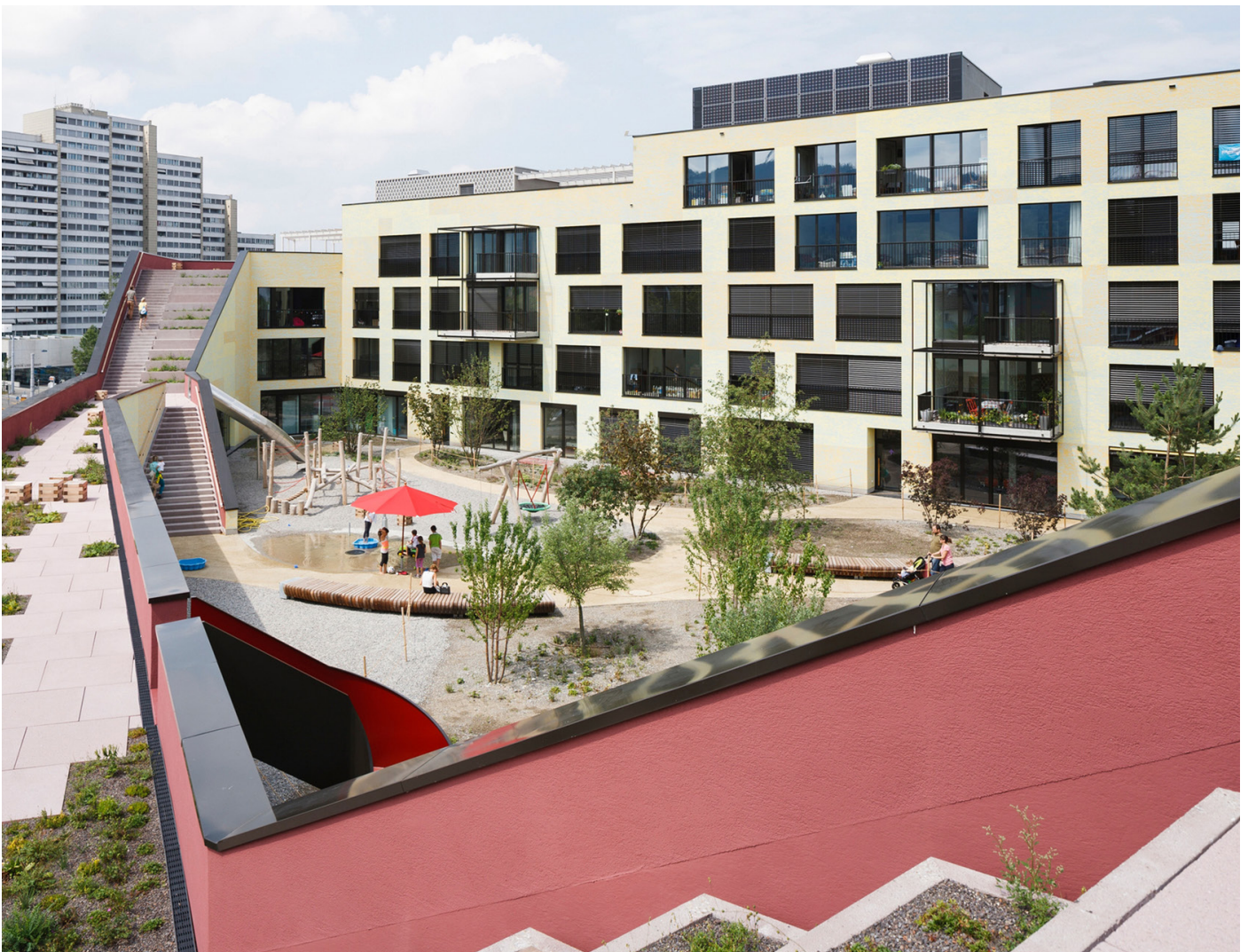
fg.2 Kalkbreite housing complex, Müller Sigrist Architekten
