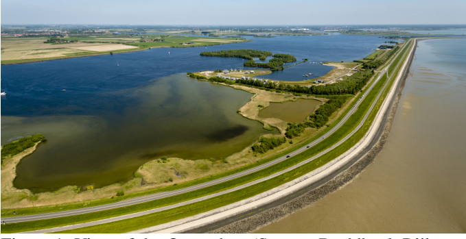
Figure 1: View of the Oesterdam (Source: Beeldbank Rijkswaterstaat (beeldbank.rws.nl)).
