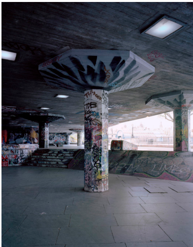
xxvii. Dankzij de centrale ligging in de stad, de bescherming tegen regen en het brutalistische ontwerp met gladde ondergrond en diverse hoogteverschillen met ramps en banks is het een zeer geliefde en (wereldwijd) populaire gevonden skateplek.
