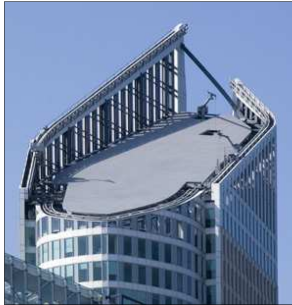
figuur 6 Dak van de Hoftoren, Den Haag; het hellende vlak bestaat uit roosters
