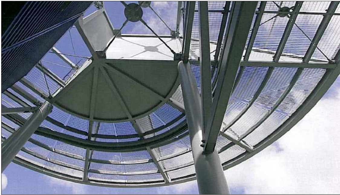
figuur 5 Roosters in de kroon van het Strijkijzer [uit: Bouwwereld #17 2007]
