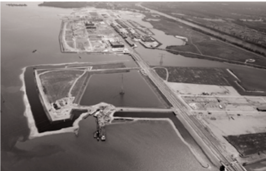
Voor de locatie IJburg in Amsterdam wordt in het IJmeer land gemaakt (foto: Projectbureau IJburg, mei 2004)
