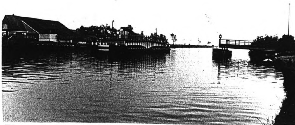
Figuur 4. Brug te Schuilenburg
