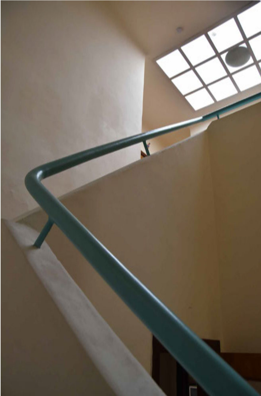
FIG. 6 Woning Vermaercke, trapruimte met bovenaan lichtkoepel [Foto: Marc Dubois]
