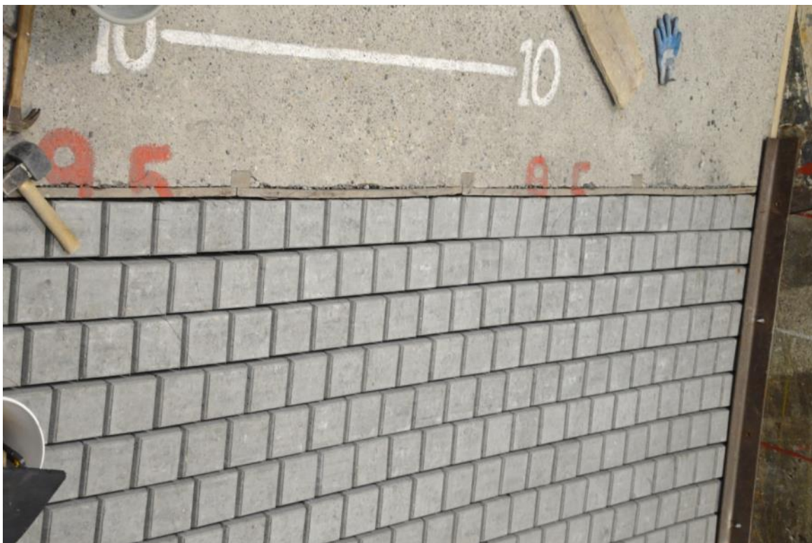
Figuur C.17 Afsluiting bovenkant van de steenzetting (voor serie 1)
