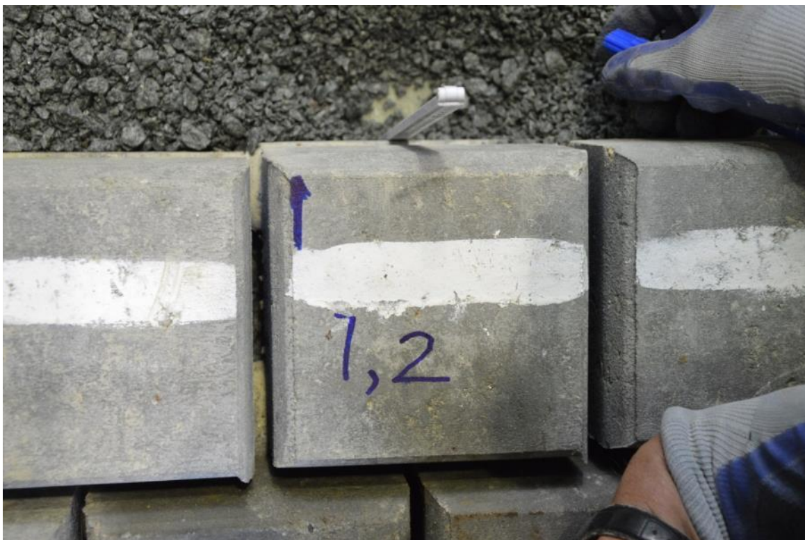
Figuur C.9 Opmeten van de filterlaagdikte tijdens de inbouw van de stenen (locatie 1,2 voor serie 2)
