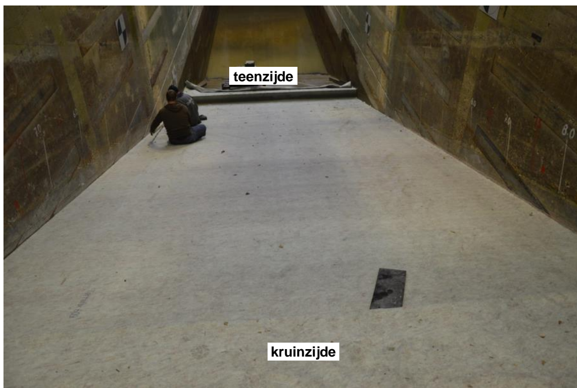
Figuur C.4 Aangebracht geotextiel voor serie 2
