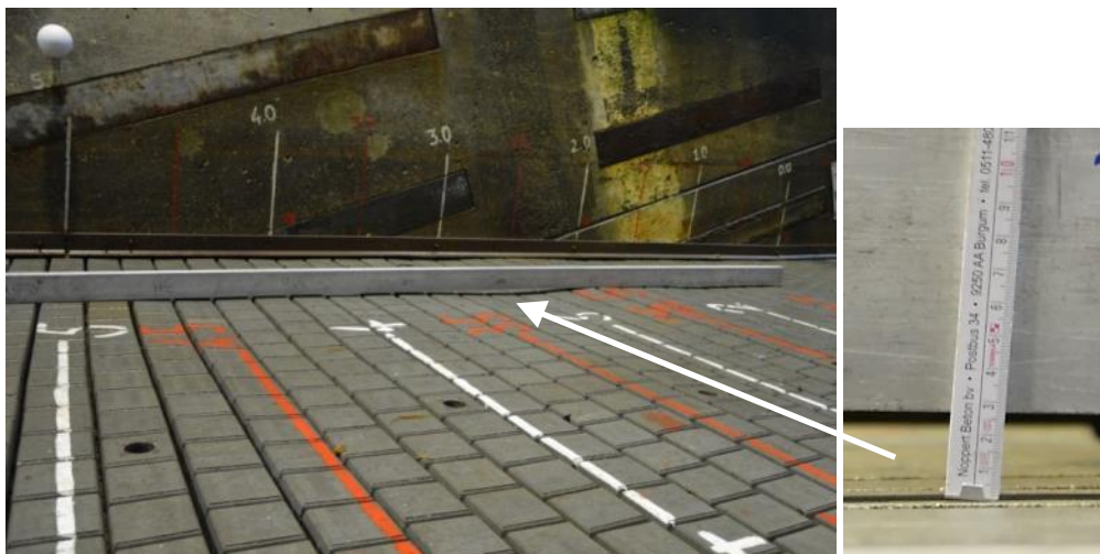
Figuur 4.14 Vervorming van het talud na proef V22
