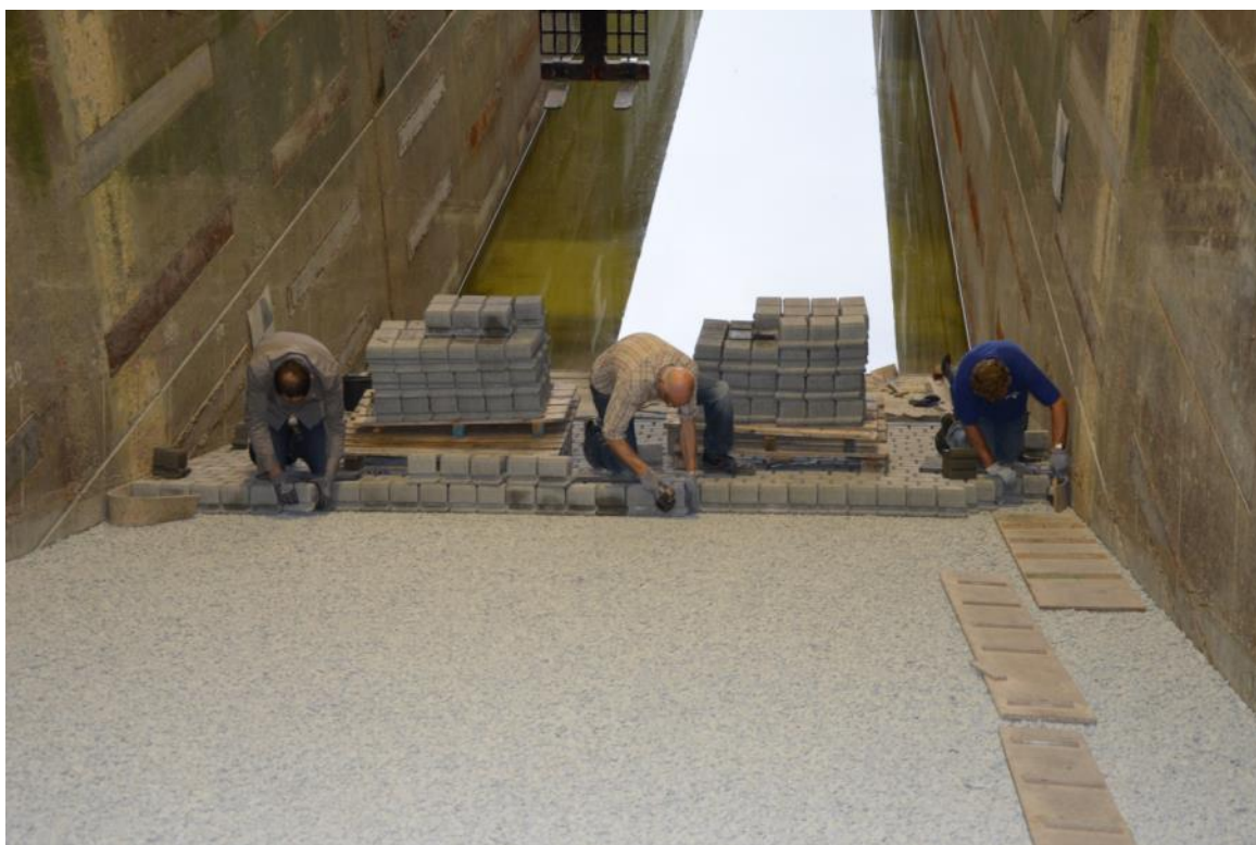
Figuur C.11 Zetten van de Verkalit stenen voor serie 1
