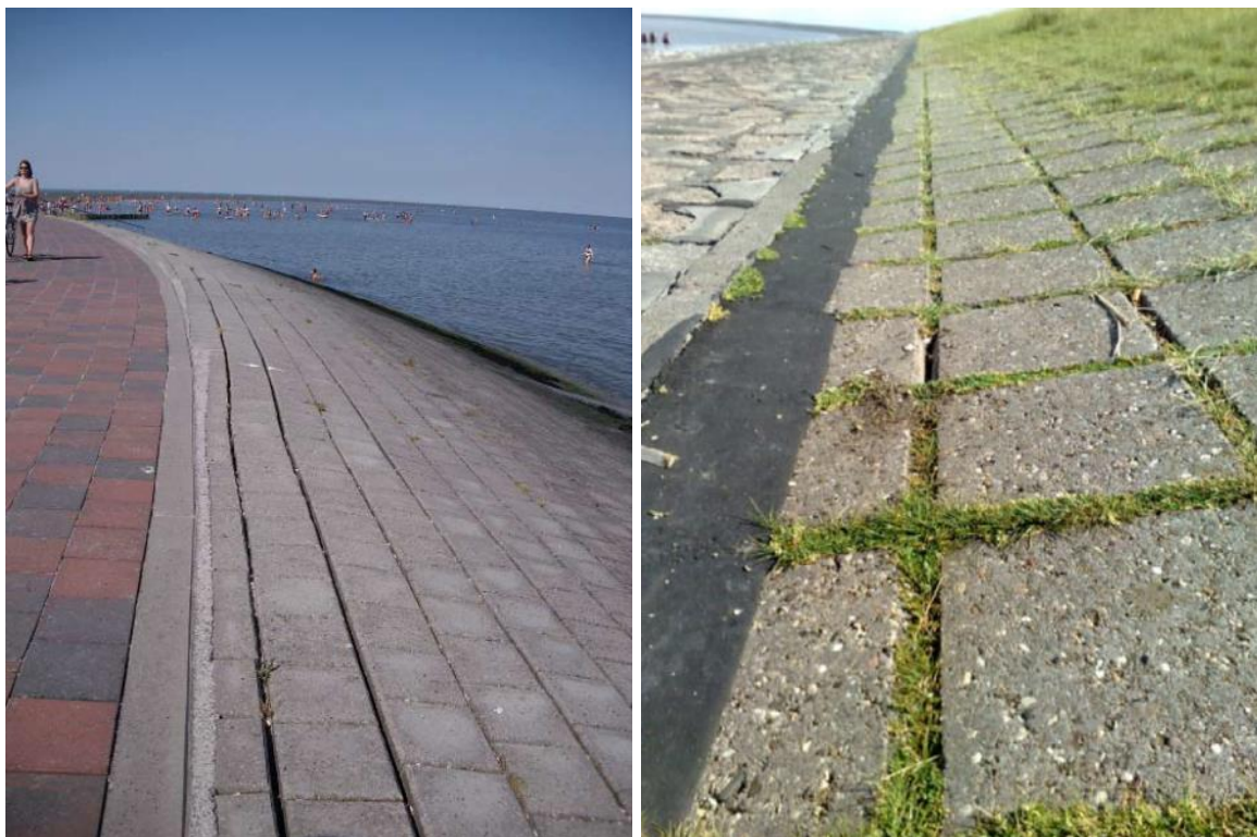
Figuur 1.3 Links: Verkalit® steenzetting bij Schillig. Rechts: Verkalit® steenzetting bij Tossens (oude gedeelte).
