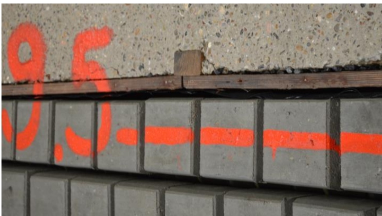
Figuur 4.3 Foto van het talud na proef V01 (boven) en van de bovenkant van de testsectie (onder)
