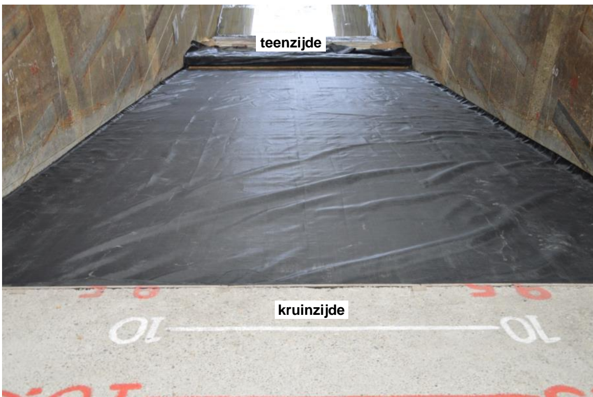
Figuur C.2 Aangebracht geotextiel voor serie 1
