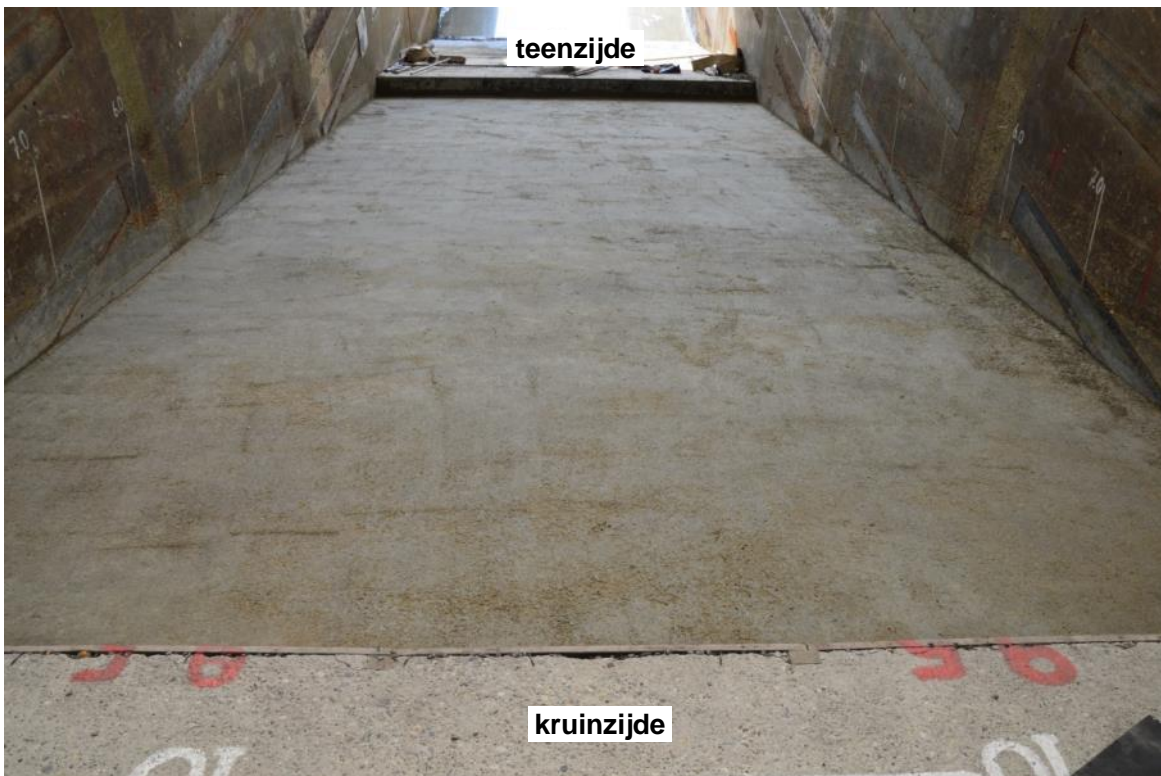
Figuur C.1 Zandcementstabilisatie als ondergrond voor de steenzetting
