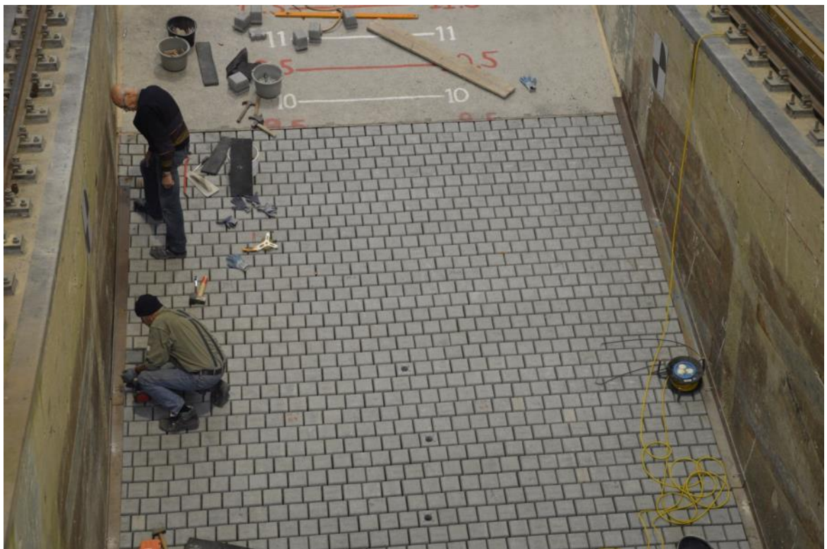
Figuur C.16 Aanbrengen van de stalen profielen aan de wanden (voor serie 1)
