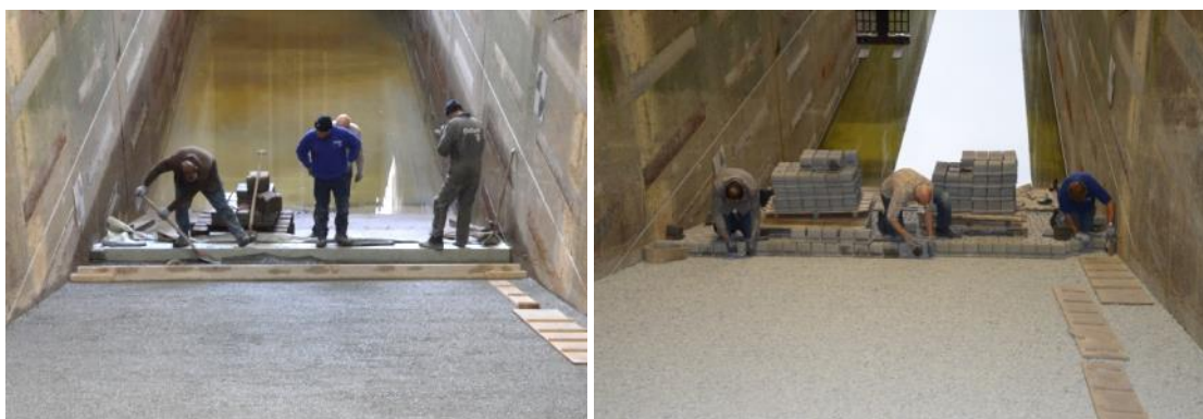
Figuur 3.4 Links: aanbrengen van de filterlaag op geotextiel. Rechts: plaatsing van de Verkalit® mgv
