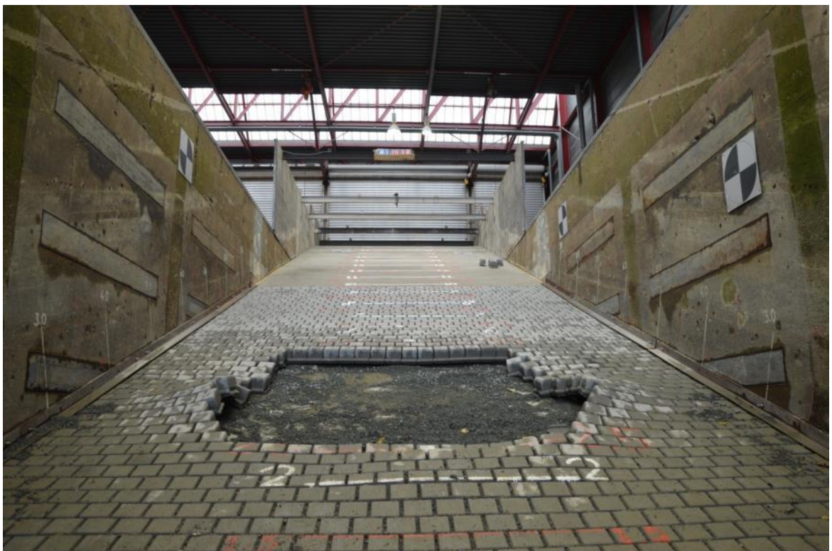
Figuur C.34 Schade na proef V10 zonder stenen
