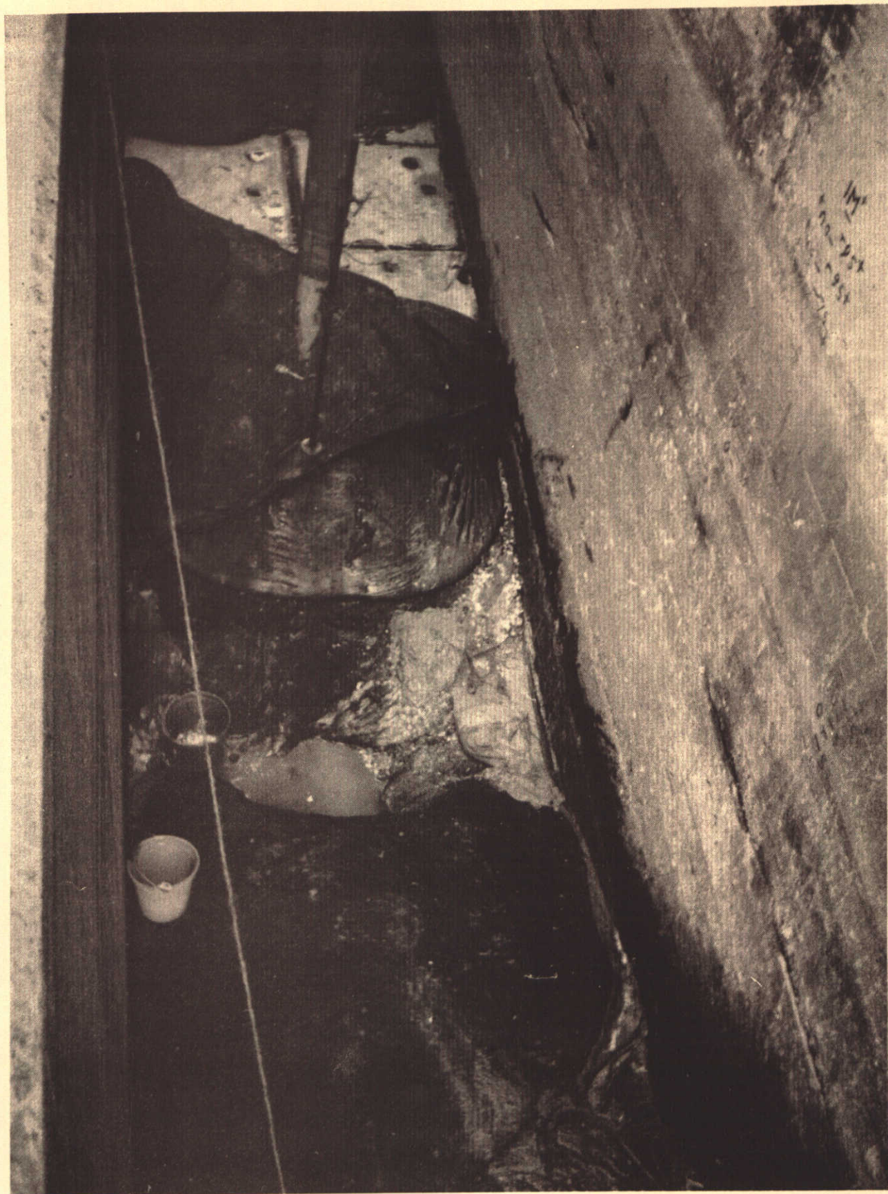
① Beschadiging na T2 (bovenaanzicht)
