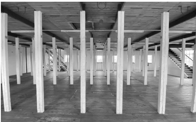
Afbeelding 2.14 - De houten standers die dienen als constructie zijn anno 2022 nog steeds terug te vinden in de voormalige bollenschuur.
