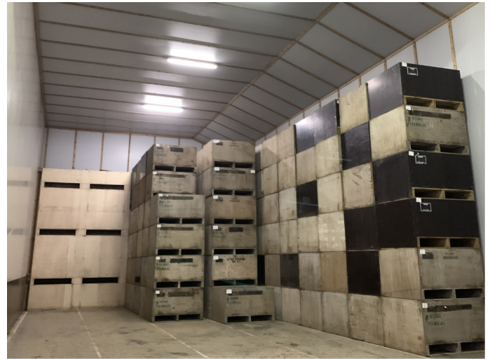
Afbeelding 2.18 - Een hedendaagse klimaatcel. Hierin zijn kuubkisten vol met bollen in opgeslagen. Voorheen stonden hier gaasbakstapels van vaak 10 tot 12 hoog. (Opslag en verwerking, z.d.)
