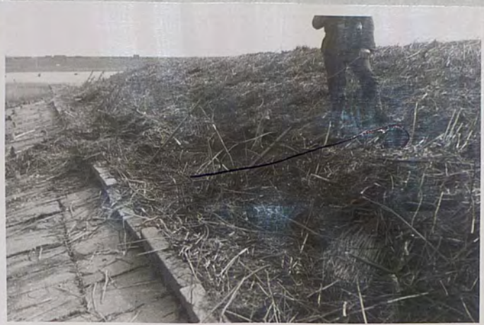
9. Gat gespoeld boven betontegels tengevolge van aanwezigheid van prikkeldraadstaken.
