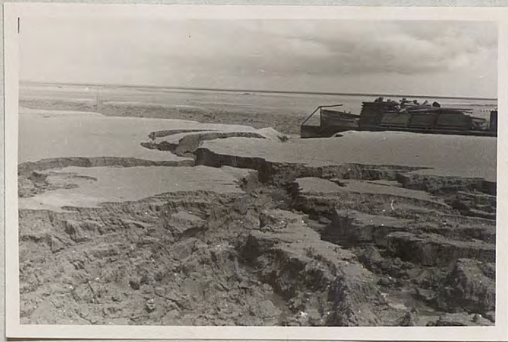
20. Boomtakvorming bij gegraven geul achter Uithuizermeeden (1942). Diepte 1.50 m
