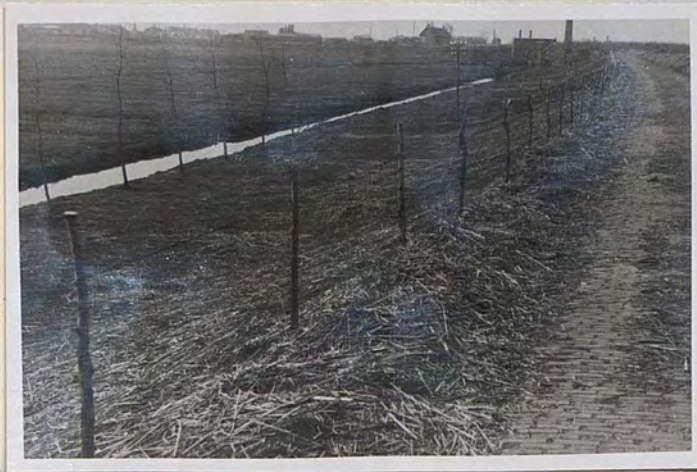
3. De veek ligt overal op het binnenbeloop. Op den achtergrond het dorp Moerdijk en het gemaal van den Royalen Polder.
