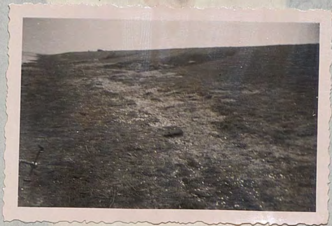
23. De Slikken. Gaten in buitentalud. Zoden weggespoeld.
