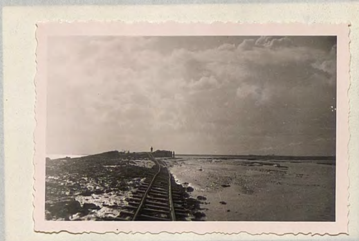
18. Idem. Resten van de binnenzijde van den dijk.
