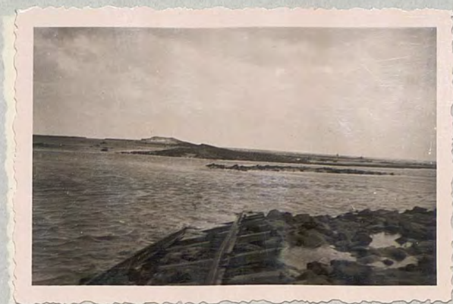
13. Uithuizermeeden. Andere doorbraak bij A. De geul naar de Bems ontstond door dit gat.
