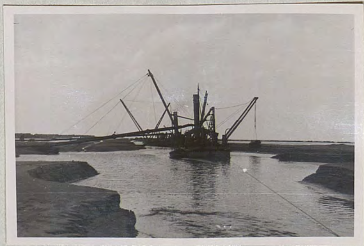
22. Gebaggerde geul voor zandwinning bij dijk Uithuizermeeden.
