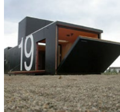
House No 19, Korteknie Stuhlmacher Architekten
