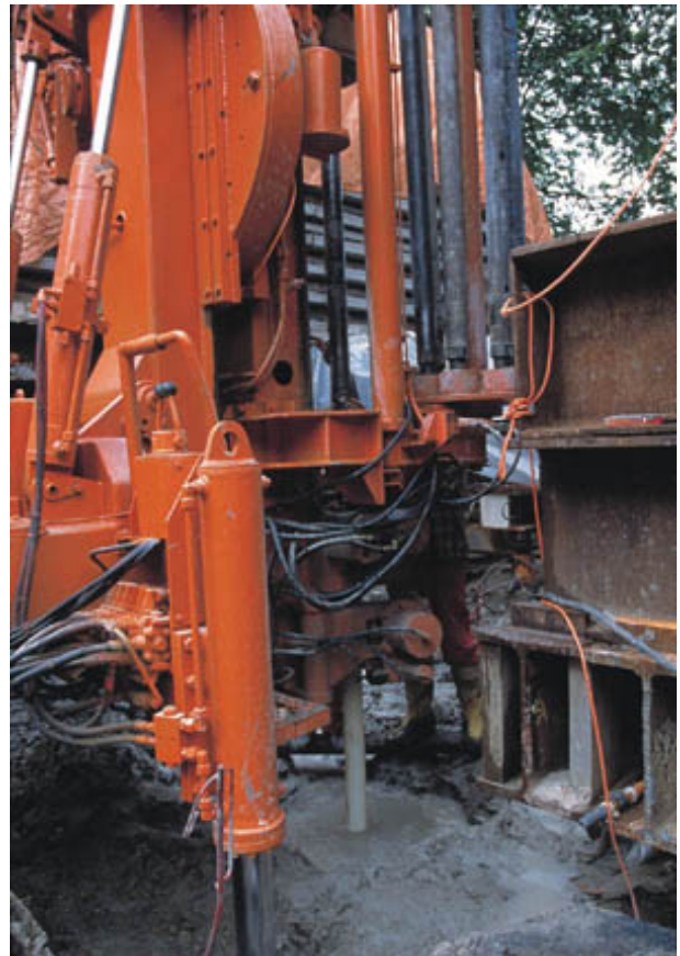
Detail van de grout-installatie, waarop de lans en de retourspoeling (spoil) zichtbaar zijn.
