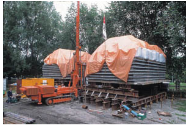
Overzicht van de praktijkinjectieproef bij de Sixhaven in Amsterdam-Noord. De mobiele groutinstallatie is bezig een jet-grout kolom naast de betonnen en houten funderingspalen te maken.
