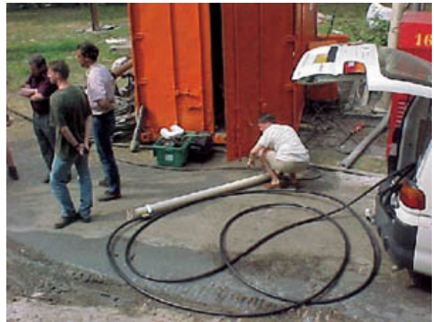
Een grondradarsonde van het Amsterdamse bedrijf T&A Radar, werd aan de jet-groutlans bevestigd om een beeld te vormen van de jet-gROUTEKOLOM.
