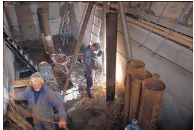
Een beproefde methode om de fundering te herstellen is het aanbrengen van gesegmenteerde palen in de kelder of op de begane grond van het huis. Deze methode veroorzaakt echter veel overlast voor de bewoners.
