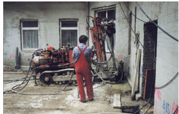
Het aanbrengen van een jetgroutpaal onder een op staal gefundeerd gebouw.
