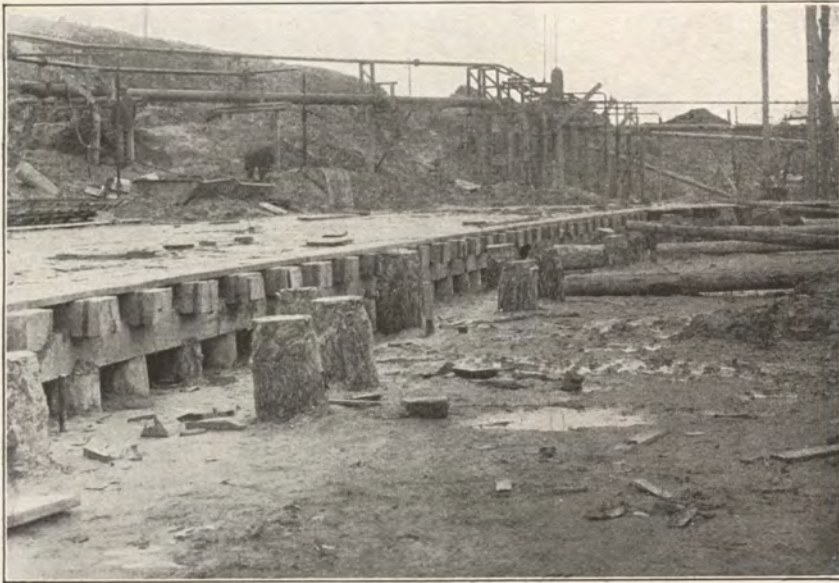
Voorkant fundeering schutkolkmuur.
