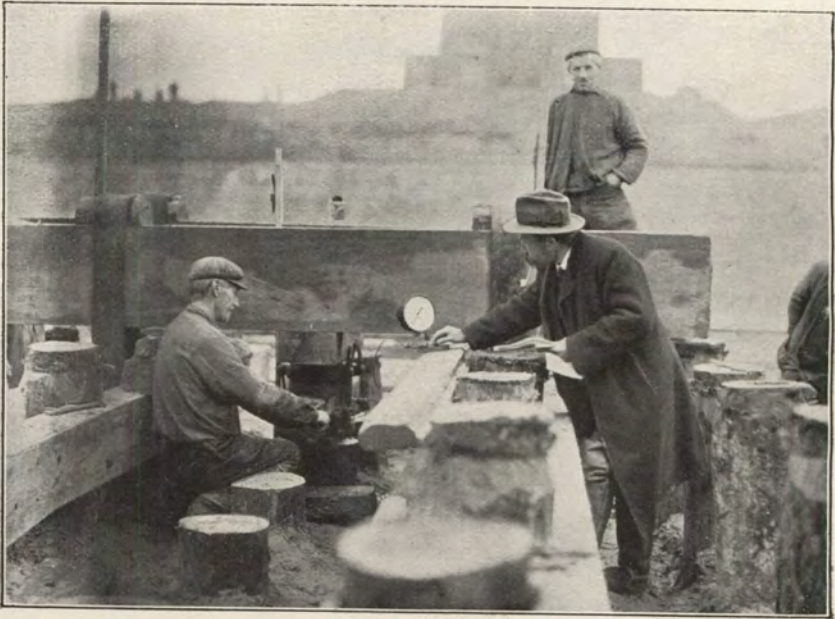
Uitvoering van de belastingproef.
