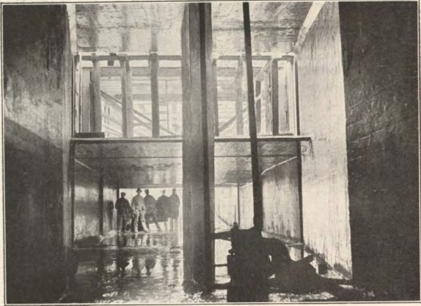
Versterkingswanden in het arbeidsriool.
