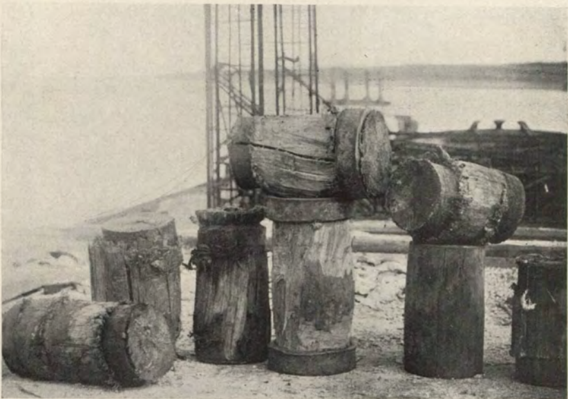
Eiken opjagers voor de gewapend betonpalen na de inheijng.
