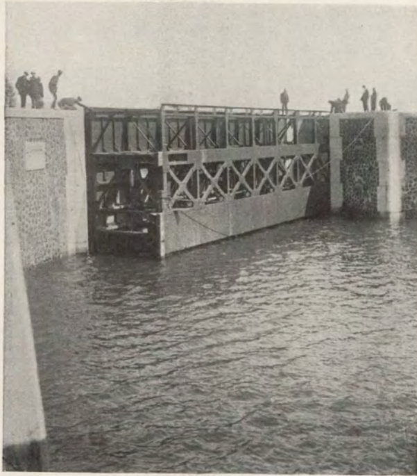
Indrijven van de deur (vooraanzicht eerste fase).
