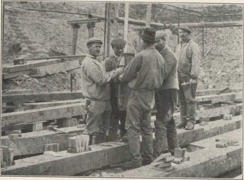
Inslaan van de wiggen in den dag der sluis.
