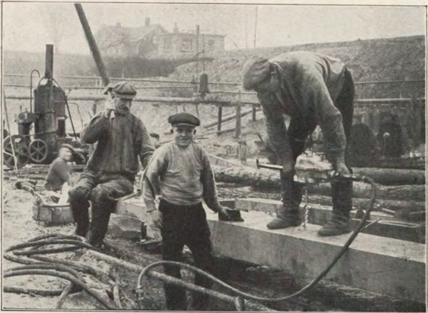
Machinaal gaten boren.
