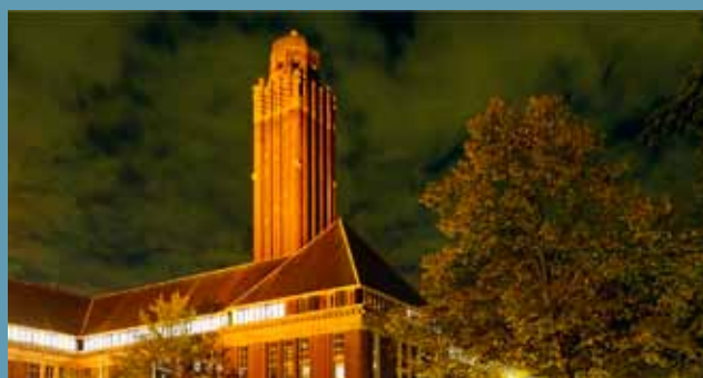
De eigen huisvesting 'BK city', Faculteit Bouwkunde, TU Delft, na de brand gehuisvest in een monumentaal universiteitsgebouw (foto TU Delft, Rob 't Hart)
