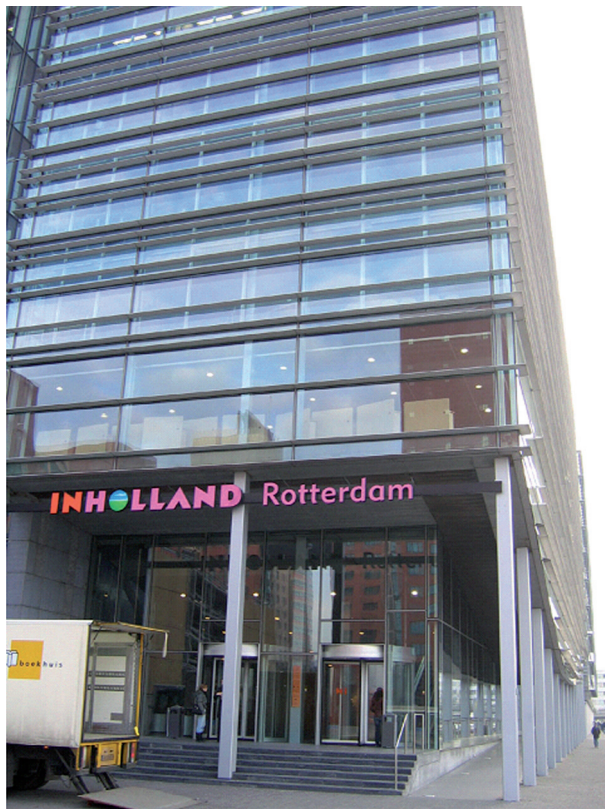
INHOLLAND Rotterdam, Kop van Zuid (Foto: W. van der Voordt, 2005)
