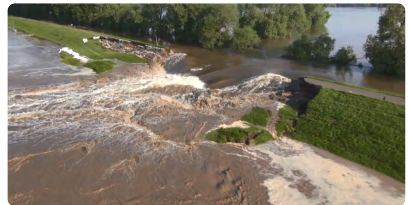
Figuur 1: Dijkdoorbraak in Breitenhagen, Duitsland. Foto door Weichel (2013) .
