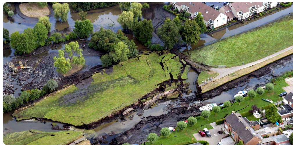
Na een plotselinge dijkverschuiving in augustus 2003, ontstond een gat in de dijk van 60 meter en overstroomde Wilnis. Foto © ANP.
