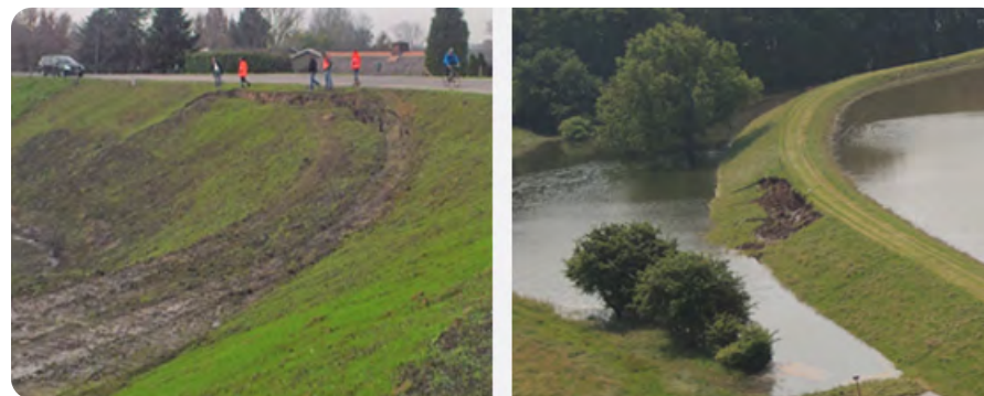
Figuur 2: Voorbeelden van taludinstabiliteit aan de landzijde met en zonder overstroming als gevolg van dijkdoorbraak. Bronnen: Landesbetrieb für Hochwasserschutz und Wasserwirtschaft Sachsen-Anhalt (LHW) en Jüpner et al. (2015).
