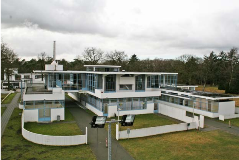
Figure 1.5 Former Sanatorium Zonnestraal (Hilversum, J. Duiker, B. Bijvoet and J. G. Wiebenga, 1928, situation 2008).
