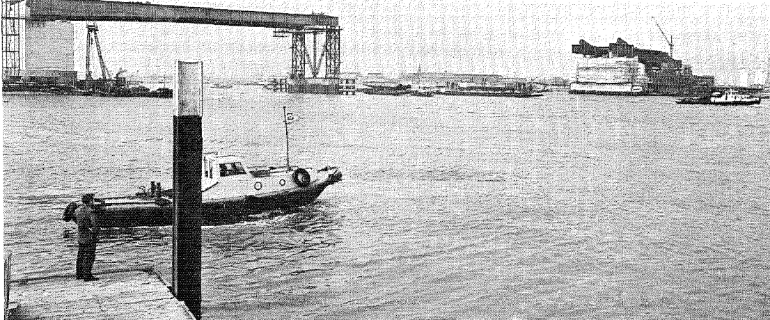
De Van Brienoordbrug bij Rotterdam in aanleg
