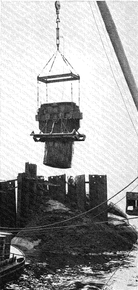
Het lossen van een asfaltkluit
