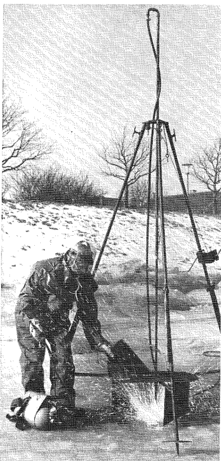
Het maken van gaten in het ijs met behulp van het z.g. lansbranden
