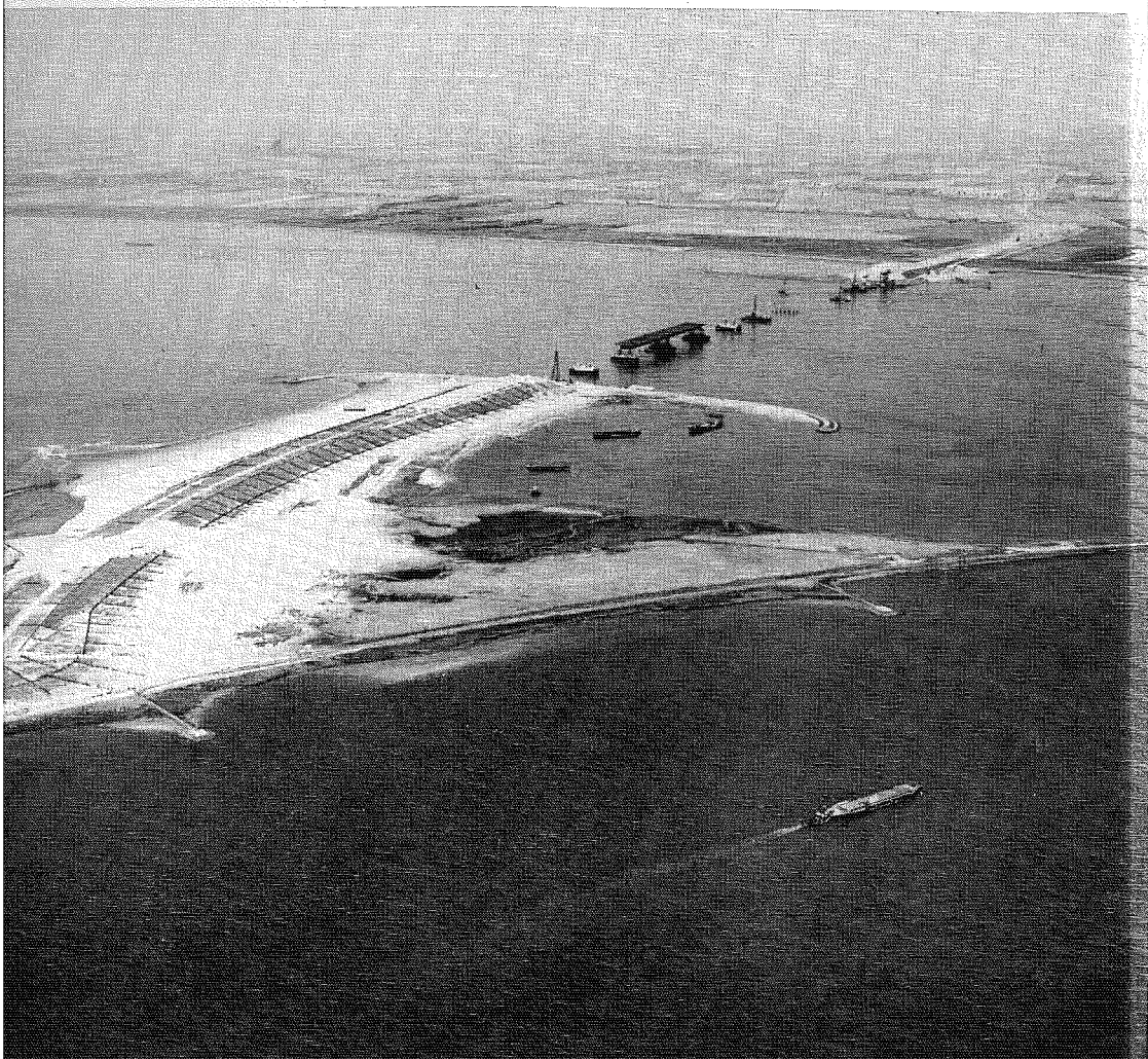
Opritten en brug over het Haringvliet bij Numansdorp in wording
