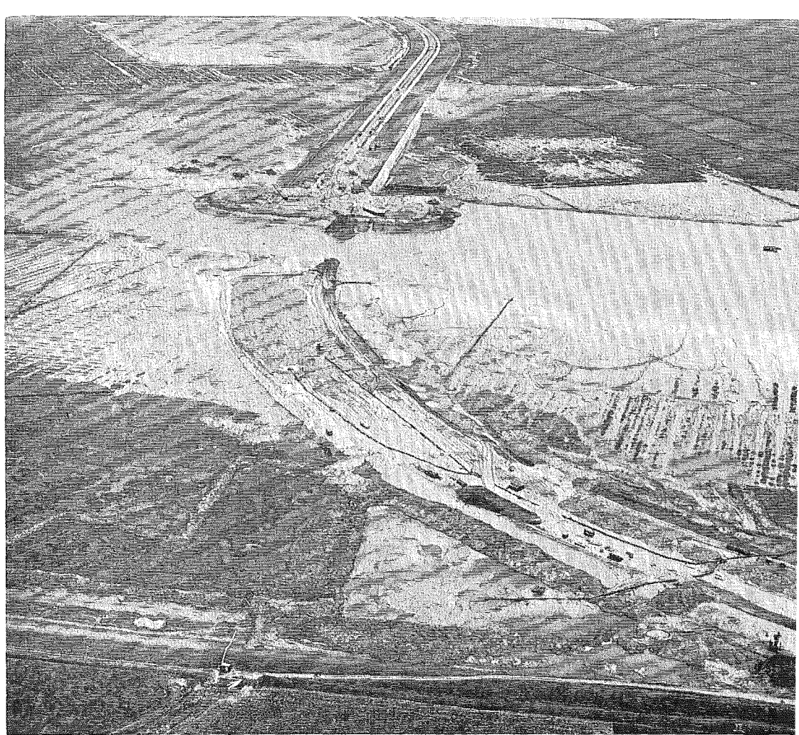
De afsluitdam van het Zuider-Sloe in aanleg. In het tracé van de dam de bouwput voor de uitwateringssluis.
