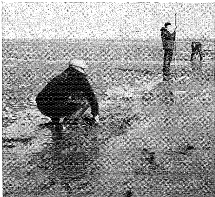
Het uitzetten van een dijkvak van de te maken afsluitdijk van de Lauwerszee
