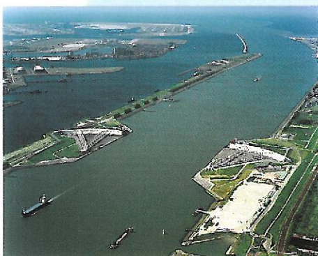
Sturmflutwehr am Nieuwe Waterweg
