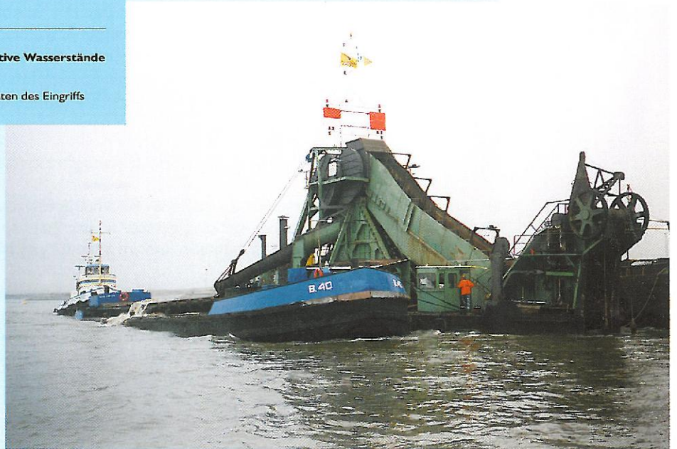
Baggermaßnahmen an der Waal
