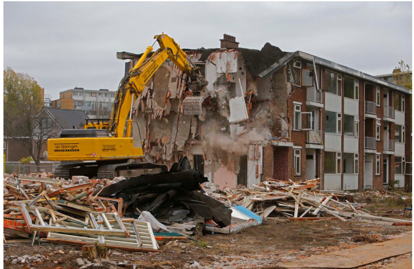
Demolition of portiekflats in Dordrecht
