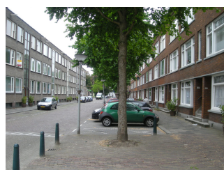
portieketage woningen Eilandenbuurt
