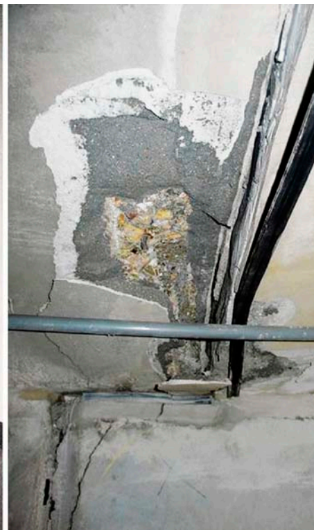
Lekwater in Drechtunnel (links) en afgeboerd beton in het dak van een tunnel.
