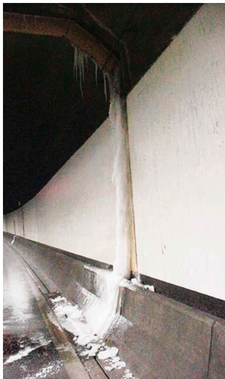
Lekwater in Drechtunnel (links) en afgeboerd beton in het dak van een tunnel.
