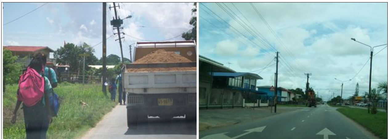
Figuur 47 Ontbreken voetpad en werkzaamheden nutsbedrijf zonder wegafzetting
