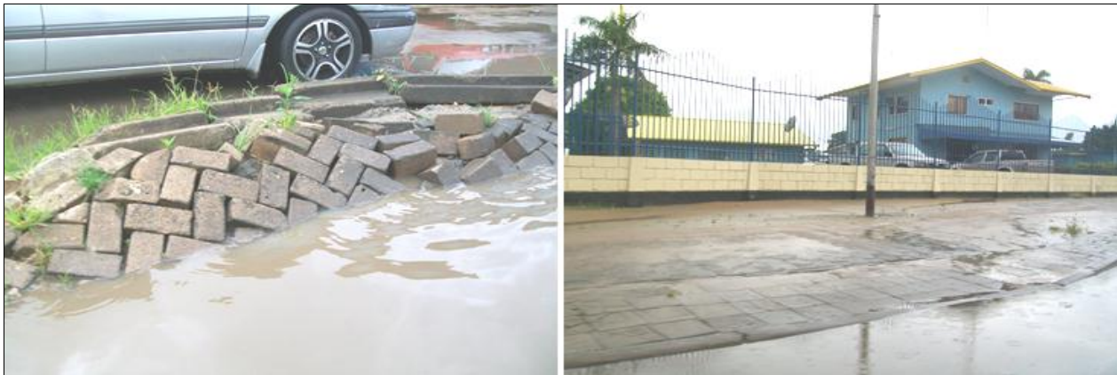
Figuur 45 Wegverzakkingen
