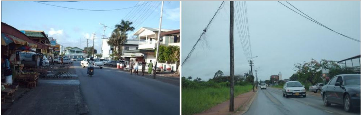
Figuur 44 Langzaam verkeer op autoweg en elektriciteitsmasten dicht op de rijbaan
