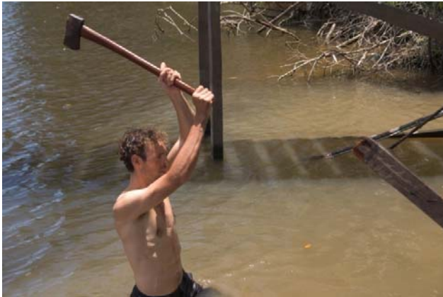
Figuur 9 Heien van de fundering voor de peillatten
