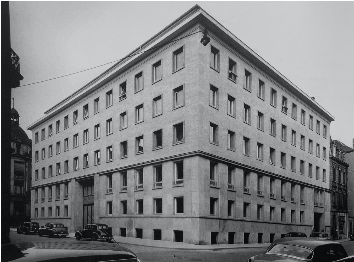
Fig. 6.: First ECSC building in the city centre of Luxembourg. ( Bâtiment de la CECA , 1973, in Administration des bâtiments publics, “Bâtiment de la CECA”, Centenaire – Administration des bâtiments publics Luxembourg , (Luxembourg: Imprimerie Faber, December 2010), p.70, photograph)
