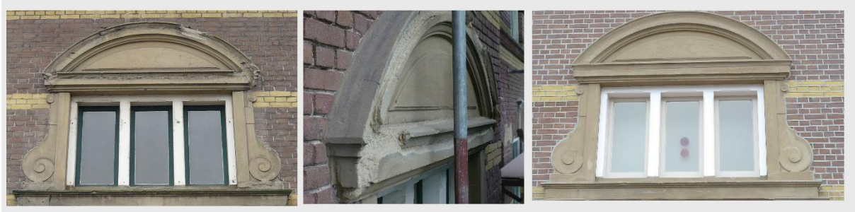
Fig. 2: Bij het voorhakken niet te veel weghalen en referentie punten laten staan.
