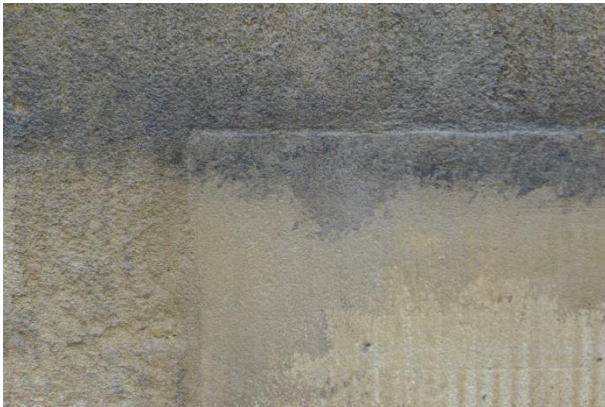
Inboeting die met retouches zijn aangepast aan het omliggende materiaal
