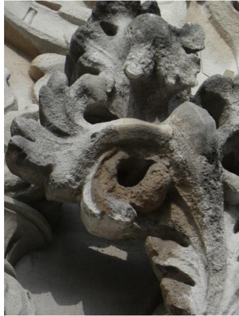
Fig. 12: Conserveren en modelleren hogel wimberg
