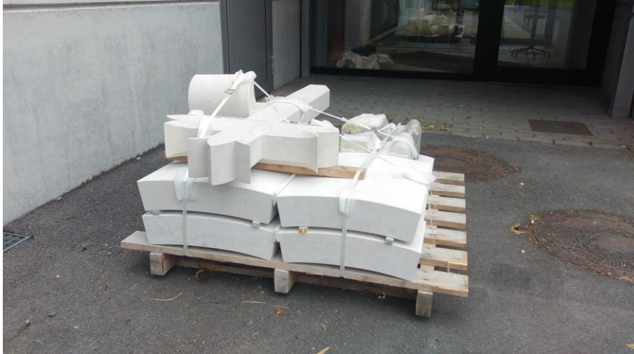
Fig. 4: Levering van nieuw gekapte stenen
