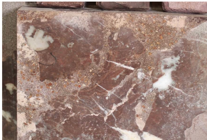
Fig. 10: Invulling met zinkmortel aangevuld met kleine roodbruine marmerfragmenten (1,8 – 2,5 mm)
