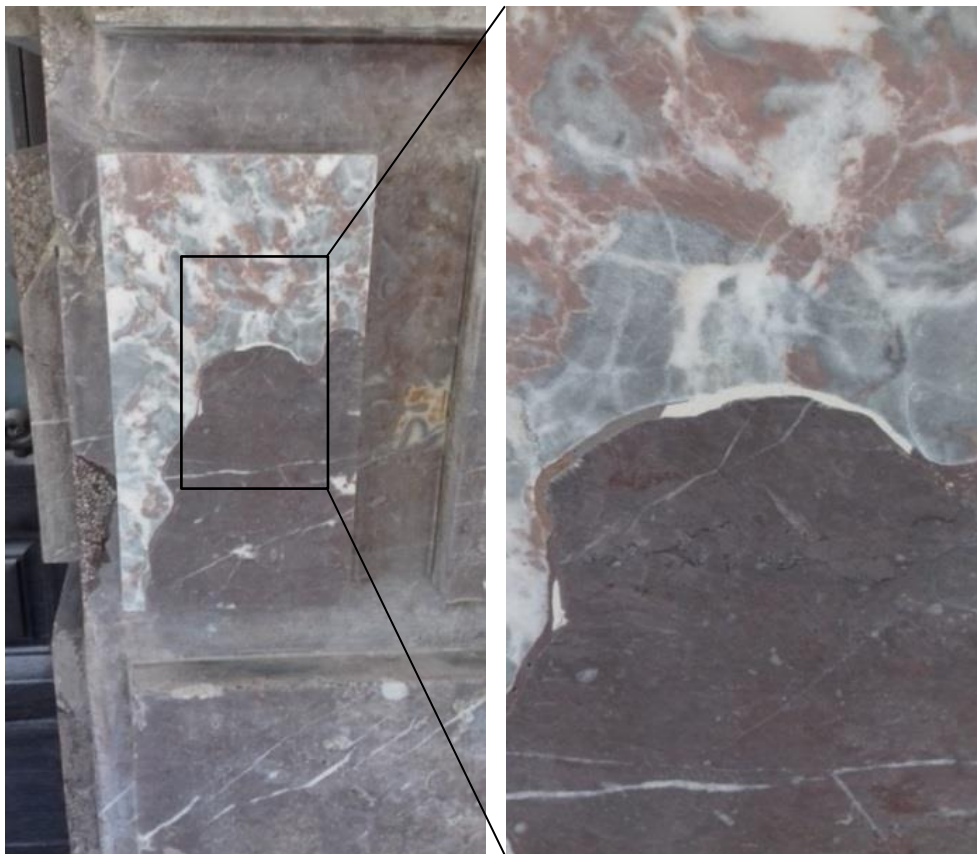
Fig. 11: Steenprothese met epoxy lijmmaad. De marmerkeuze van de steenprothese integreert niet met de donkerrode tint van het te herstellen rood marmer
