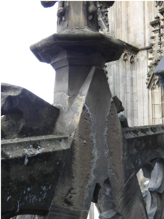
Fig. 2: Herstel Udelfanger zandsteen met een harde cementgebonden mortel
