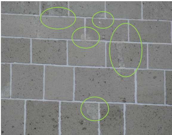
Fig. 7: Reparaties van tufsteen met M70 tufsteen reparatiemortel en ontstoord met mineraalverf
