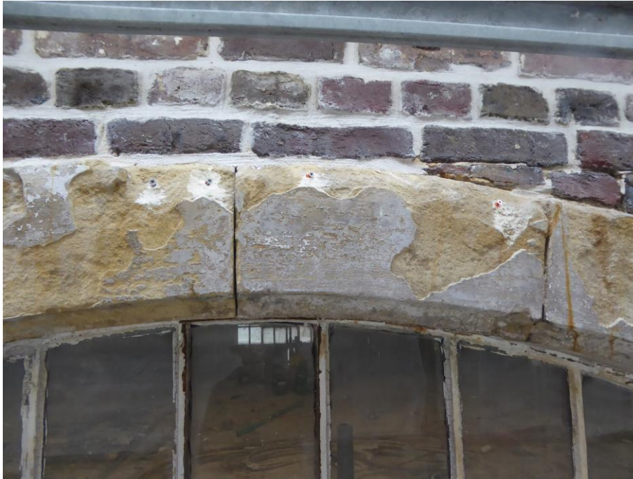
Fig. 9: Raamomlijsting voor restauratie en na het aanbrengen van de rvs doken
