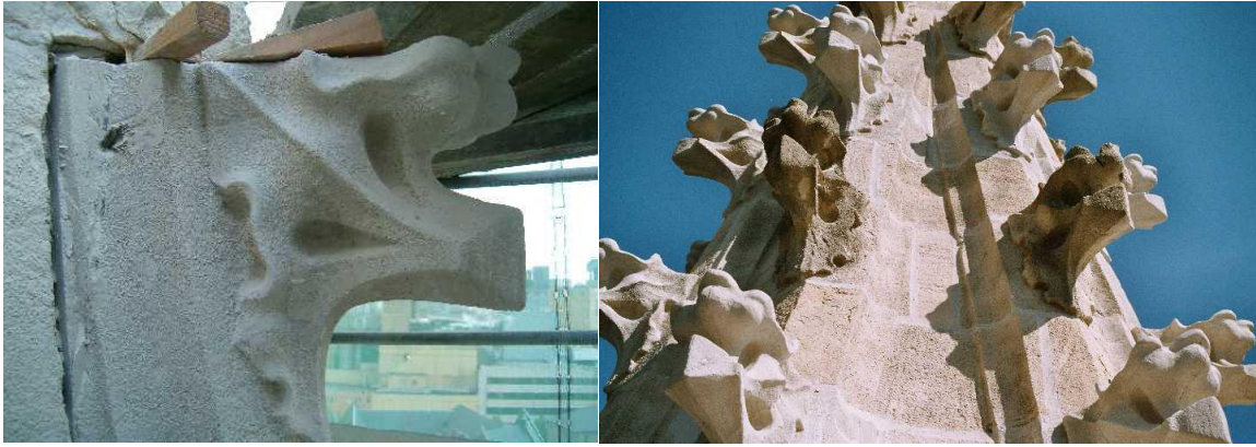
Fig. 1: Sint-Martinuskerk Aalst: Herstelling hogels met kunststeen © agentschap Onroerend Erfgoed
