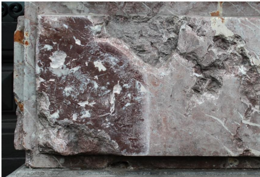
Fig. 6: Kleurverschil na het opschuren van het marmer. Na het schuren (zone links) krijgt het marmer zijn karakteristieke dieprode kleur terug
