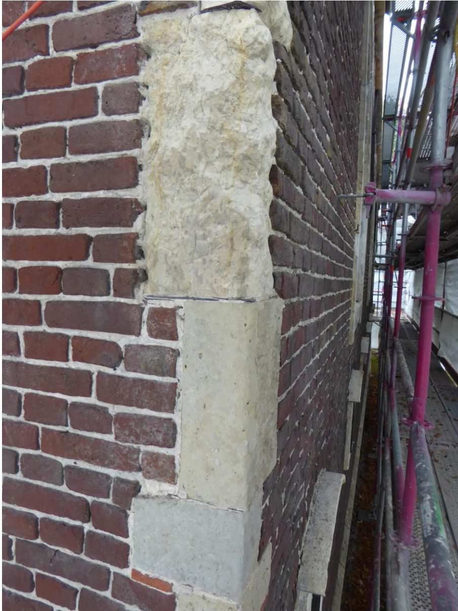
Fig. 14: Verweerde hoekblok in Avesnessteen (boven) en weinig verweerde Ledesteen (onder)
