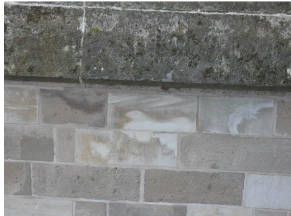
Fig. 5 en 6: Reparaties met reparatiemortels van zandsteen blokken. Duidelijk is de ontkleuring van de Jahn M70 natuursteenherstelmortel zichtbaar
