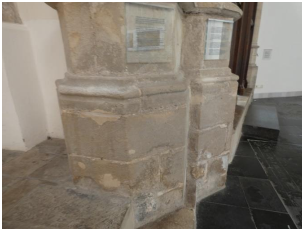
Fig. 13: Reparaties met Monulit kalksteen reparatiemortel
