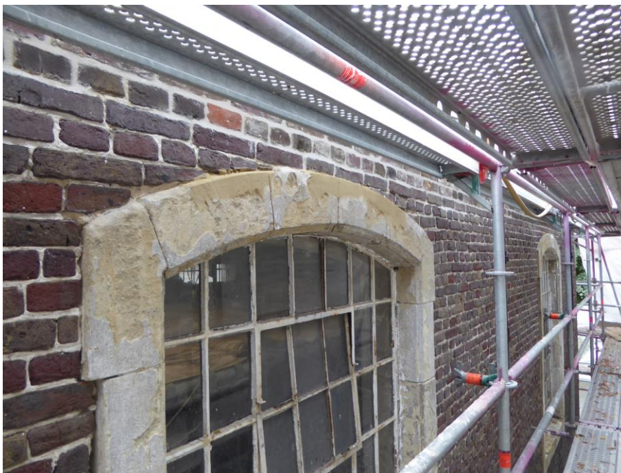
Fig. 10: Raamomlijsting na aanvulling met kalkmortel. De mortel is nog niet uitgedroogd waardoor de kleur nog te donker is
