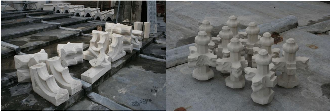
Fig. 3: Onze-Lieve-Vrouwkathedraal te Antwerpen: onderdelen in kunststeen © Steenmeijer Architecten BVBA
