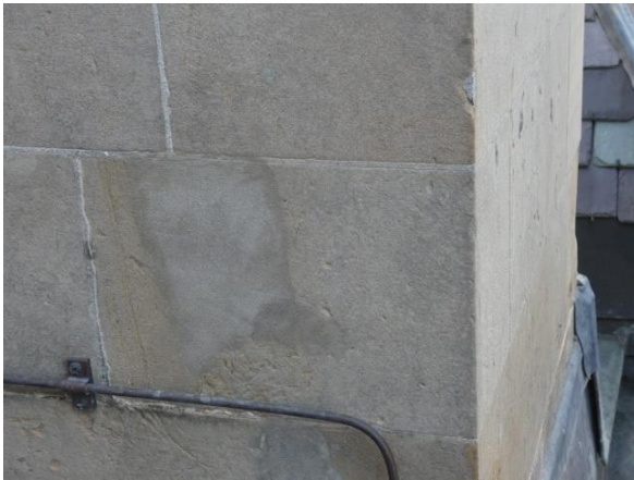
Fig. 5 en 6: Reparaties met reparatiemortels van zandsteen blokken. Duidelijk is de ontkleuring van de Jahn M70 natuursteenherstelmortel zichtbaar
