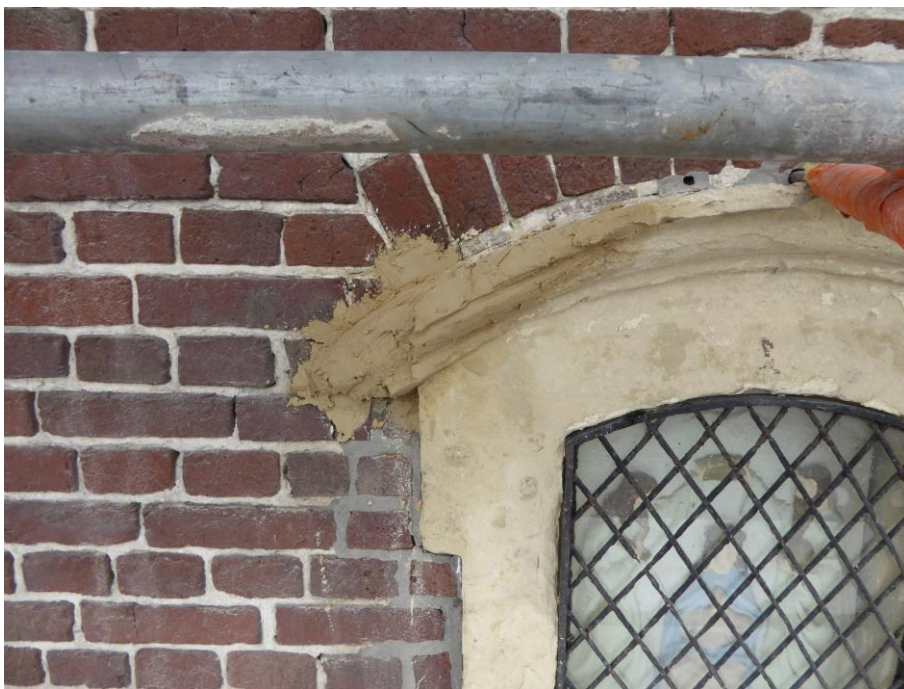
Fig. 12: Lacune tijdens het aanzetten van de mortel
