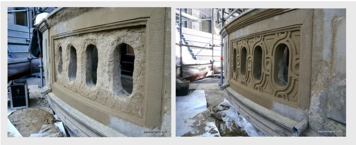
Fig. 3: Mortelrestauratie van een balkon (Kneuterdijk, Den Haag).
