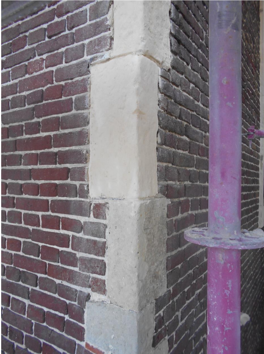
Fig. 15: Hoekblok na bepleistering
