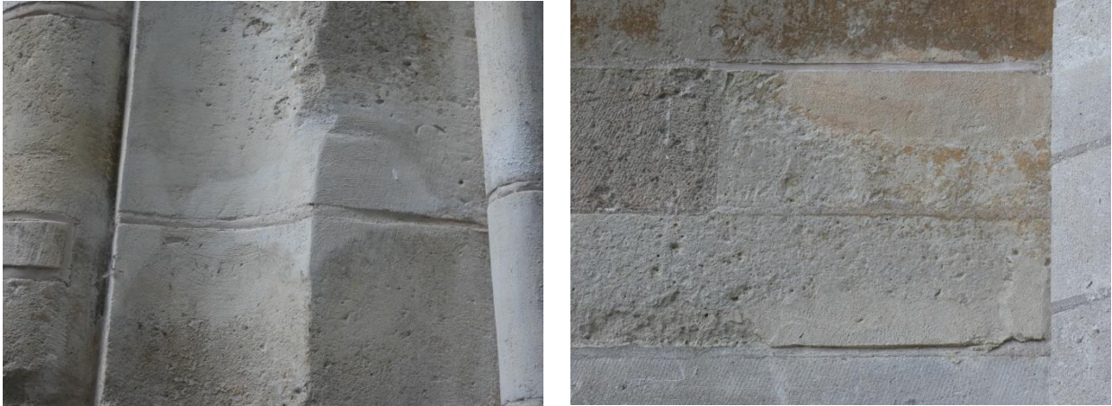
Fig. 9 en 10: Reparaties van kalksteen met M70 kalksteen natuursteenreparatiemortel. De reparaties zijn hier op grond van technische noodzaak uitgevoerd, zodat het voegwerk kan worden aangebracht en de afwatering verzekerd is
