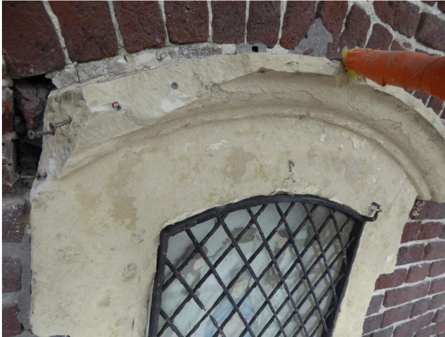
Fig. 11: Lacune in de lijst van één van de statiekapellen
