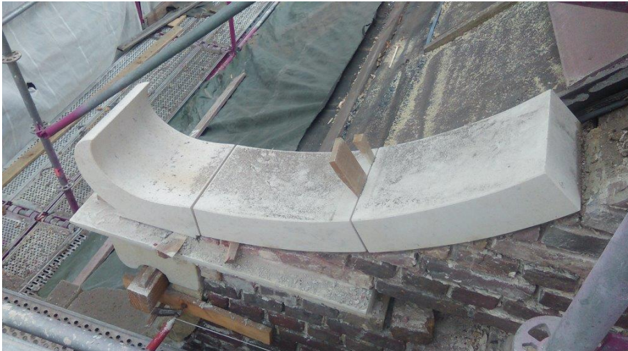
Fig. 3: Steenvervanging van de halfronde boog met Massangis Roche Jaune Claire
