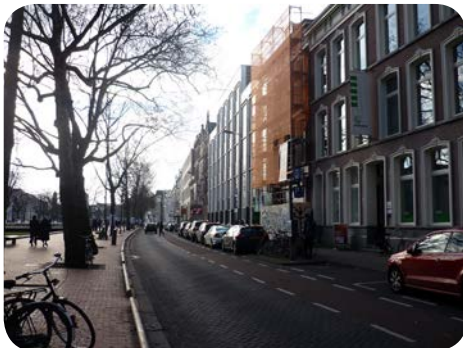
Figuur 9.6. De doorgaande gevelwand bakent de ruimte af, maar zorgt ook voor structuur
