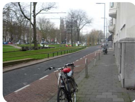
Figuur 9.16. Het trottoir wordt van de rijweg gescheiden door middel van fietsbeugels. Tussen tramlijn en rijweg is een stalen hekje geplaatst
