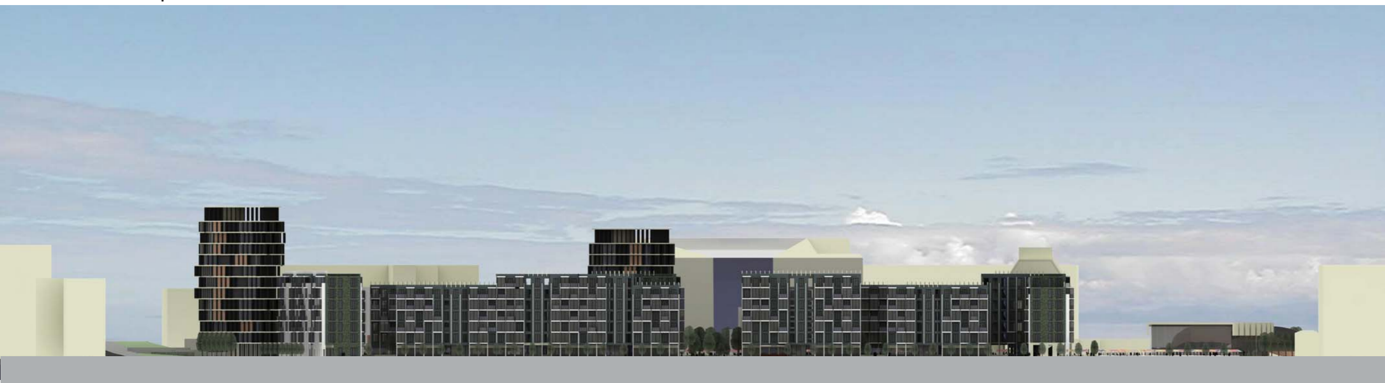
Gevel Köpenicker strasse
