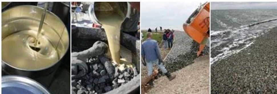
Abbildung 9: Arbeitsschritte beim Einbau von Elastocoast (Elastogran)
