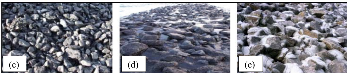
Abbildung 6: Verklammerte Deckwerke: Mastix-Schotter (c), Asphaltverguss (d), Betonverguss (e) (Staal, 2008)
