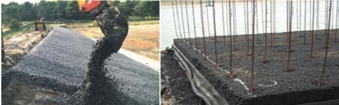
Abbildung 8: Mastix-Schotter beim Einbau in situ und als Mastix-Schotter-Platte (Hesselberg Hydro)
