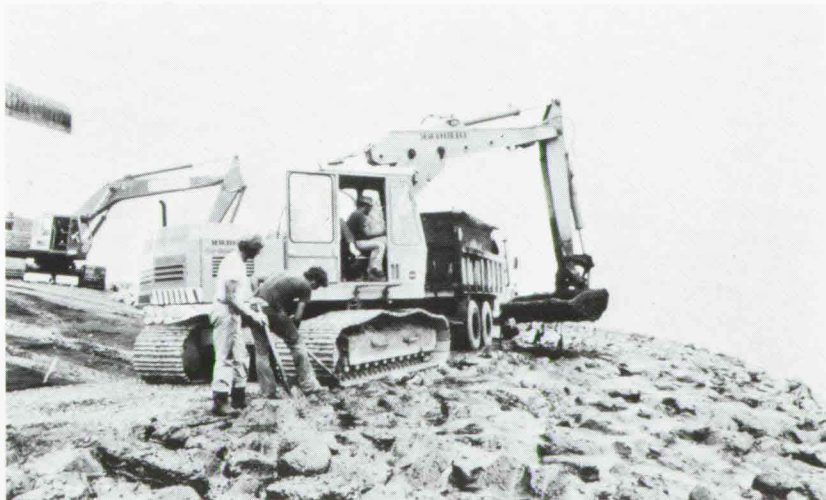
Figuur 7: Aanbrengen van een penetratiemortel met de bak van de hydraulische kraan
