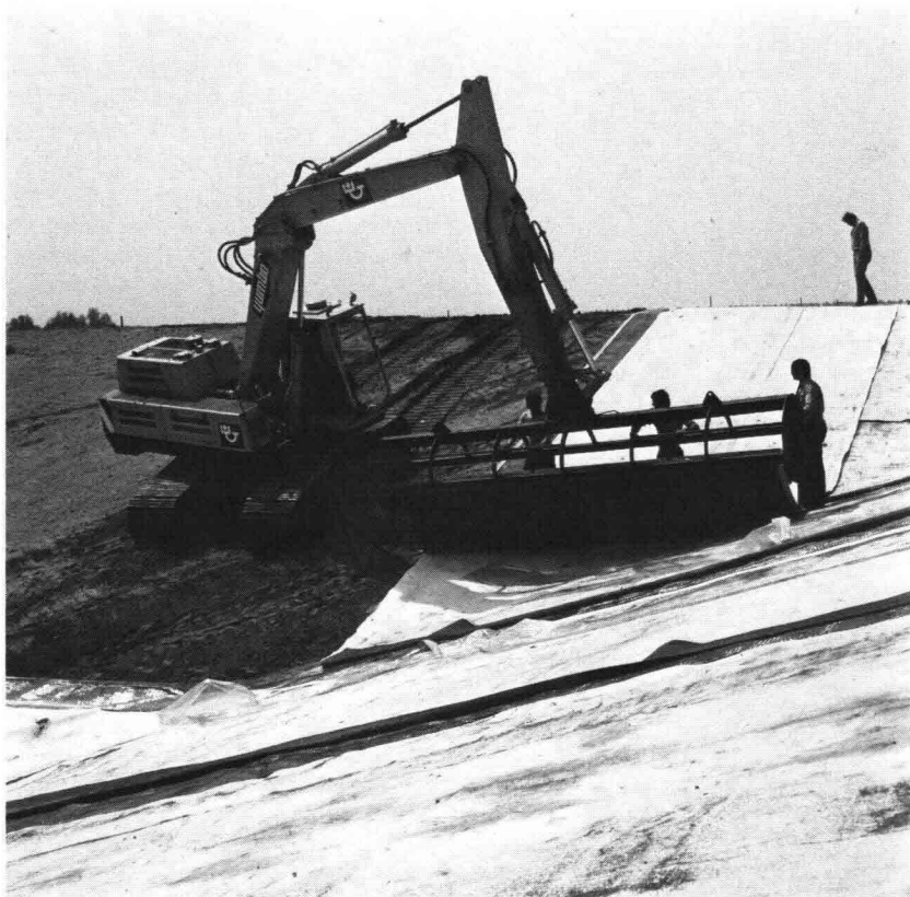
Figuur 14: Aanbrengen van een ge- prefabriceerd membraan
