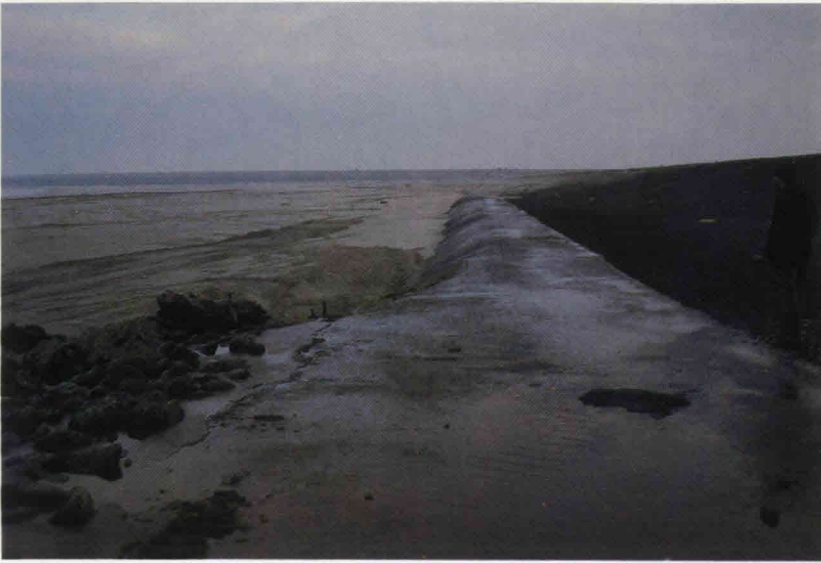
Figuur 3: Een door een mastiekslab gevolgde ontgroning voor een dijk
