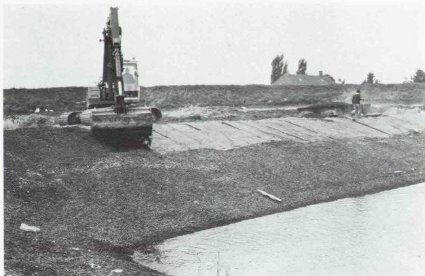
Figuur 8: Aanbrengen van open steenafalt op een filter- doek
