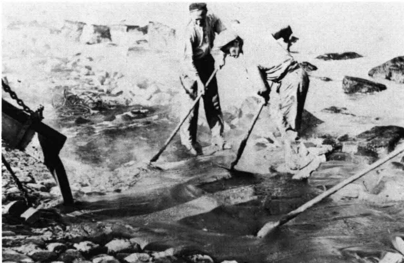
Figuur 28: Penetratie van de basaltbekleding van de strandhoofden bij Delfland
