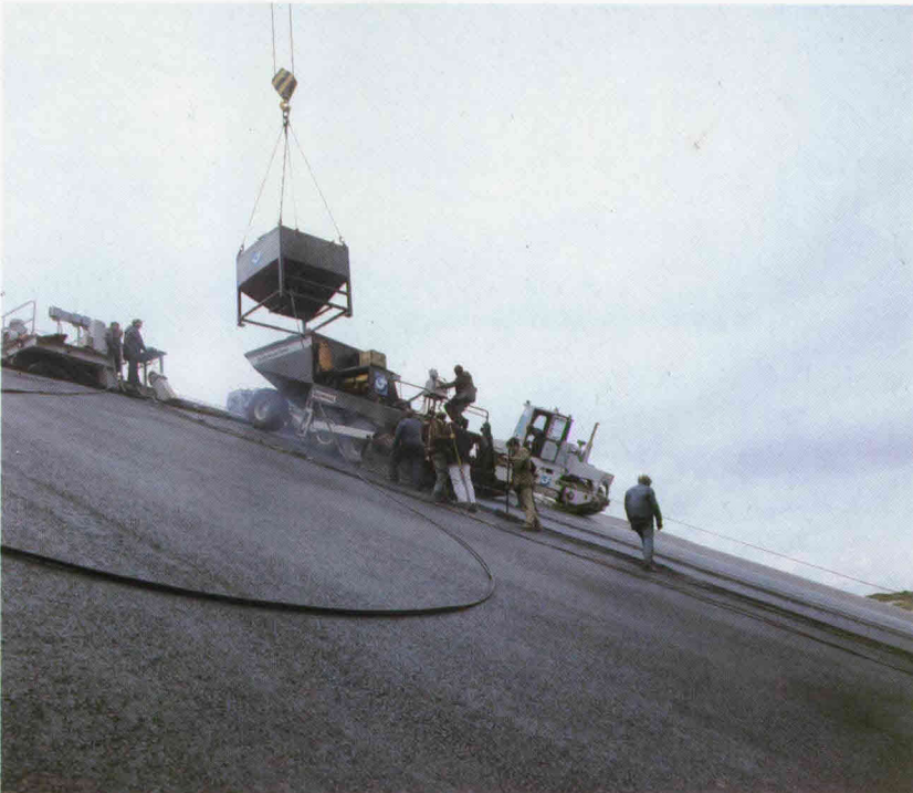
Figuur 5: Aanbrengen van een asfaltbetonbekleding met een voor toepassing op het talud aangepaste spreidmachine
