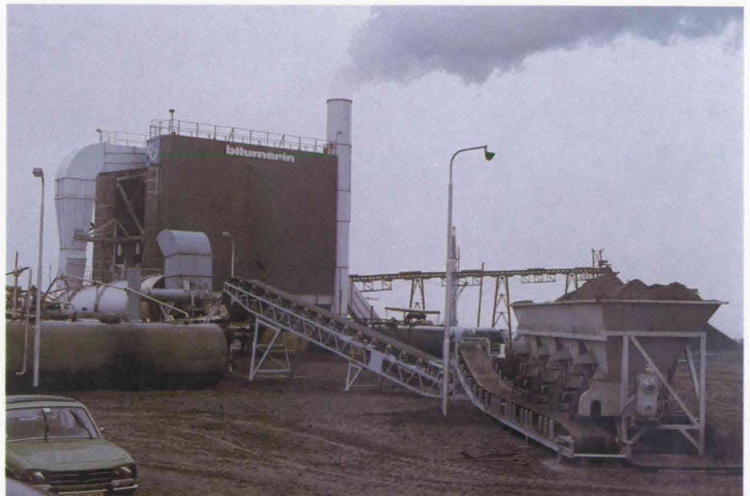
Figuur 1: Installatie voor de produktie van gebitu- mineerd zand te Zee- brugge
