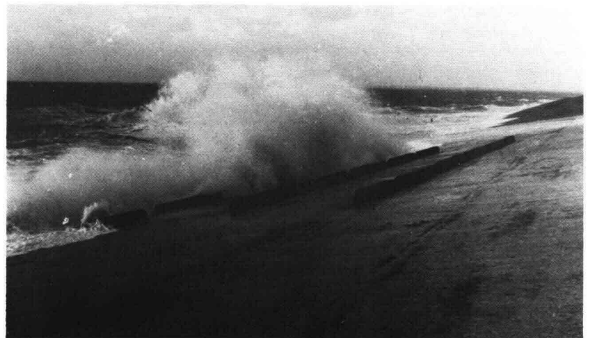
Figuur 18: Ribbels ter beperking van de golfloop
