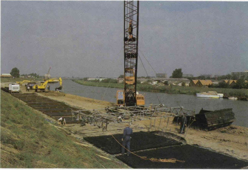
Figuur 9: Vervaardiging van open steenafalmmatten
