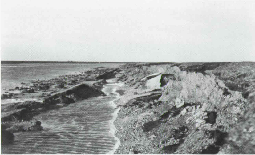
Figuur 3: Schade aan binnenbe- loop zomerdijk ten ge- volge van reeks storm- vloed en in 1973.
