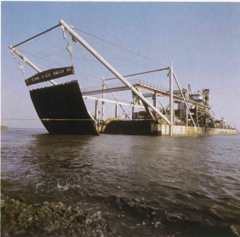
Figuur 10: Aanbrengen van een open steenafalmmat door het afalmschip „Jan Heymans”
