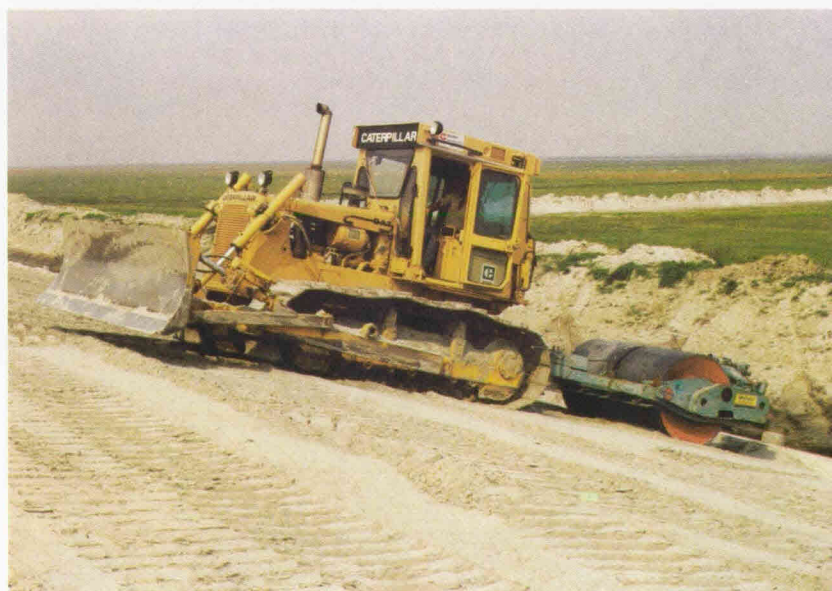
Figuur 6: Verdichting van het zandlichaam met een trilrol
