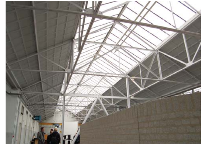
daken met lichtbanen
