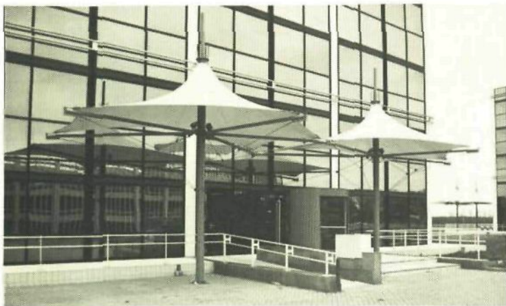
140 Modular Tent structures in office projects in Hoofddorp (See par 3.7.14).
