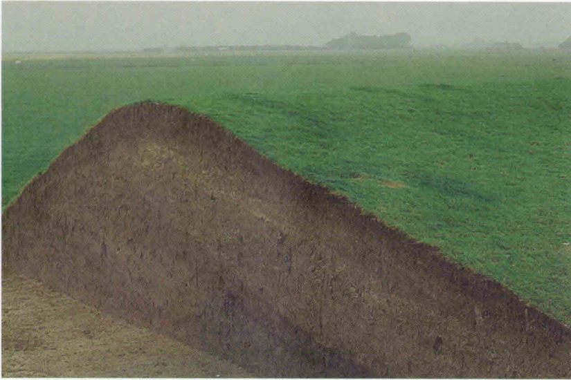
Doorgraving voormalige primaire dijk bij Holwerd; zode in Deltagoot getest op erosiebestendigheid
