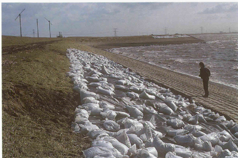
Op sommige plekken is klei weggespoeld tot gaten van 40 m 2
