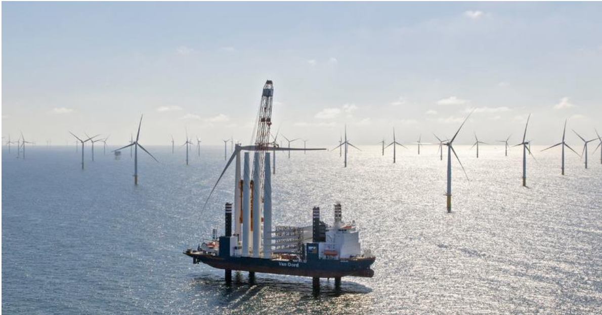
Figure 10 Aeolus of Van Oord installing wind turbines (Van Oord, n.d.b)
