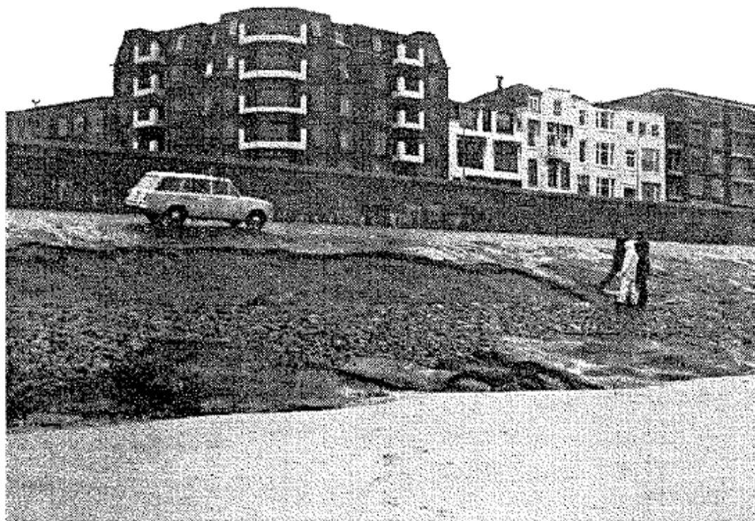
foto 10. Schade ter hoogte van Coosje Buskenstraat.
