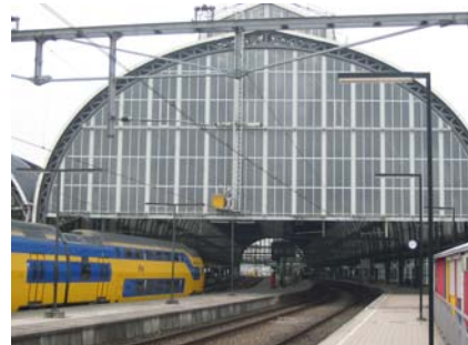
Figuur 4.17 3 e Kapconstructie
