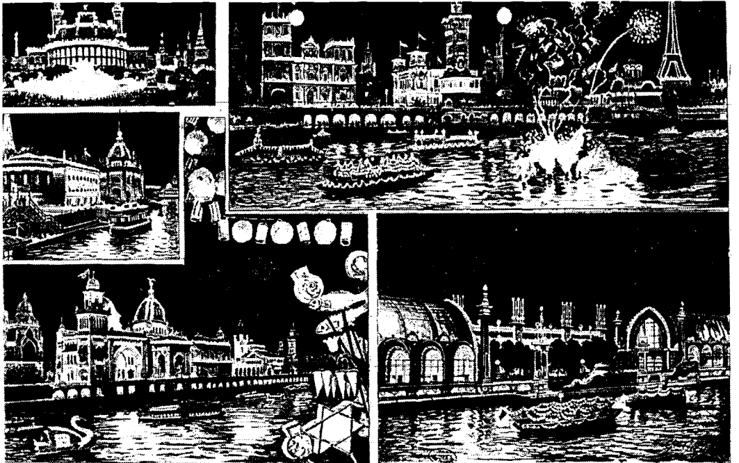
De electricificatie maakte de avondlijke verschijning van de expositie en de 'fêtes de nuit' tot een onvergetelijke gebeurtenis en een regelrechte cultuurschok voor het negentiende eeuwse publiek, dat overwegend nog slechts vertrouwd was met de spaarzame en flakkerende verlichting met gas of olie. De entreepoort veranderde s' avonds in een feeriek moors aandoend lichtkunstwerk van zwiepende vuurtorenlichten, overdekt met zachtjes gloeiende rode, groene, blauwe en gele edelstenen (gekleurd glas met lampjes erachter) (151). Een al even betoverende metamorfose ondergingen de Seine-oevers en de nationale paleizen; een vrolijke lichtarchitectuur als passend decor voor de nachtelijke Fêtes venétiennes met hun vuurwerk, lampions en optochten van bizarre en feestelijk versierde boten (152).
