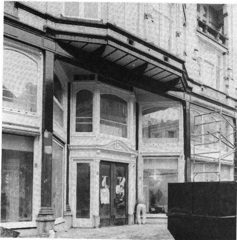
het toegevoegde toegangsportaal
